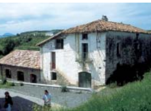
El antiguo molino de Azorito, en Puente la Reina, antes de su rehabilitación
