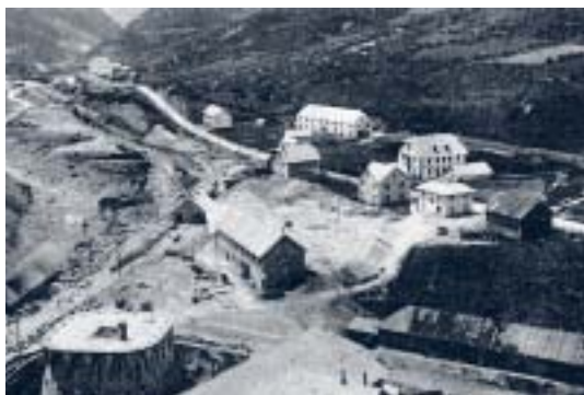
La explanada de Los Arañones (Canfranc) en 1911, durante los trabajos de construcción del túnel y de la Estación Internacional
