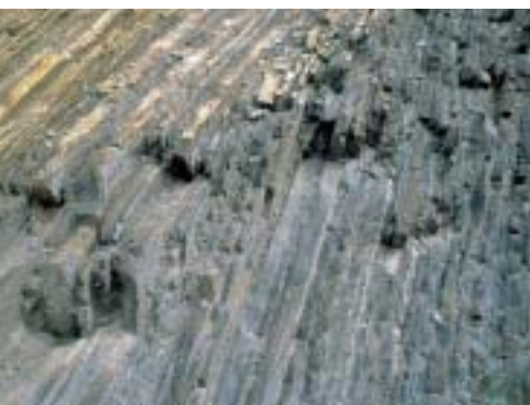
Corte en la zona de flysch
