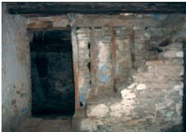
Patio inferior, con puerta de acceso a las cuadras, escalera de acceso a la planta superior (parcialmente expoliada) y muros interiores de mampostería y entramado de maderos en una casa de la comarca
