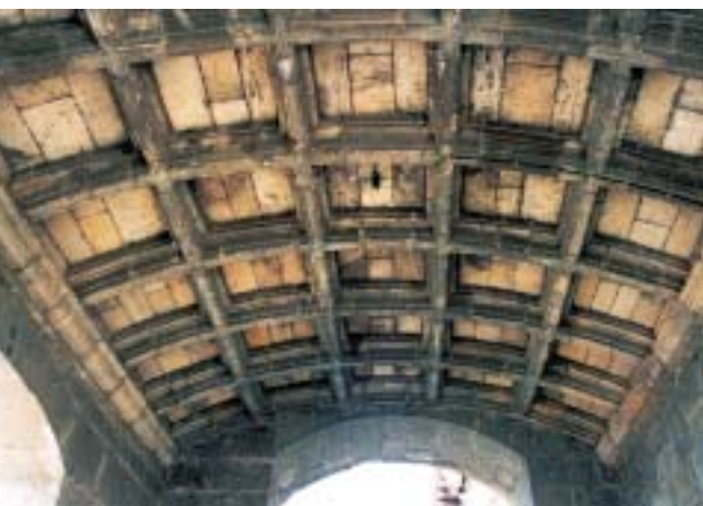
Bóveda acasetonada de la sacristía de la parroquial, en Salvatierra de Esca
