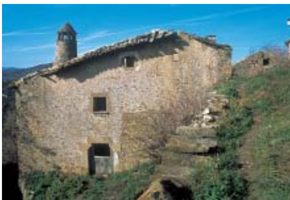
Casa tradicional en Arrés, con escasos vanos en la fachada, chimenea troncocónica y tejas que sustituyen al tejado de losas
