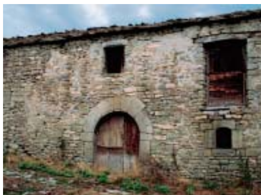
Baraguás. Los sillares se reservarán generalmente para puertas, ventanas o esquinas
