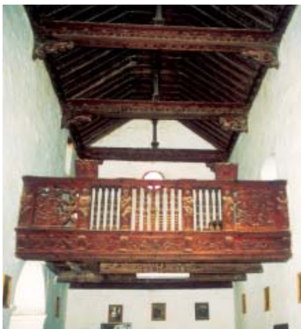
Antepecho del coro, y parte de la techumbre, de la iglesia parroquial de Mianos
