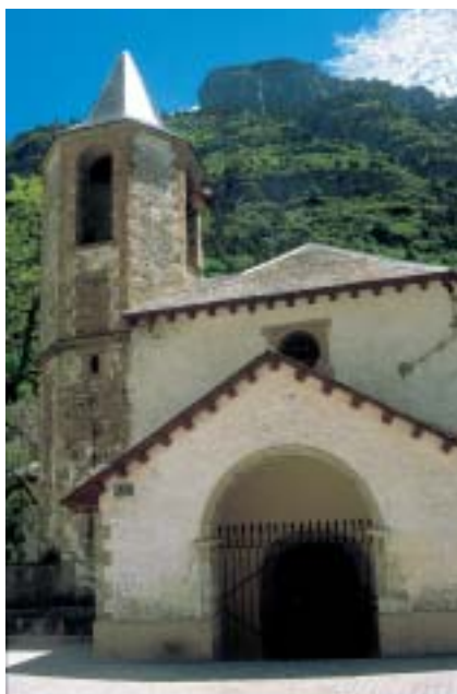
Iglesia parroquial de Nª Sra. de la Asunción de Canfranc, en cuya construcción intervino el maestro Juan de Segura hacia 1522
