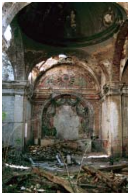
Interior de la iglesia parroquial de Tiermas (uno de los escasos templos neoclásicos de la comarca) arruinada, como el pueblo, tras la construcción del embalse de Yesa
