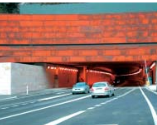
El túnel carretero del Somport se abrió al tráfico en enero de 2003. En la imagen la boca sur en Los Arañones (Canfranc)
