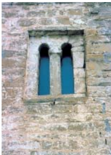
Ventana geminada en la torre de San Adrián de Guasillo
