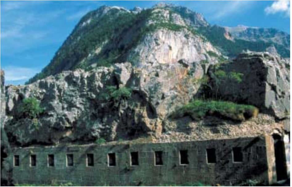
Fuerte de “Coll de Ladrones” (Canfranc). Galería aspillerada en el foso y, al fondo, el monte de La Cantalera
