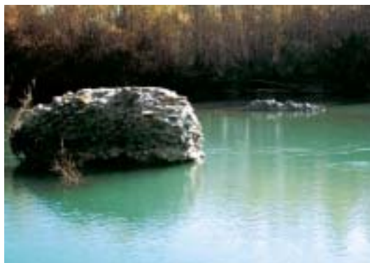
Mianos, "Los Pilares": restos del antiguo puente sobre el río Aragón
