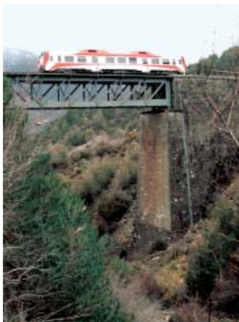
Viaducto en la línea ferroviaria del Canfranc
