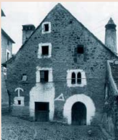
Casa en Hecho subdividida para dos viviendas. Fachada de mampostería enlucida, reservando sillares para los marcos de los vanos. Dos puertas: la más antigua de medio punto, la otra adintelada. Ventana ajimezada, de tradición gótica, en el primer piso. Enlucado en los aros de los vanos, con alguna concesión caprichosa. Chimenea tradicional, troncocónica, en la vivienda de la derecha: la otra es de planta rectangular. Cubierta de tejas planas (A. Mas, 1917)
