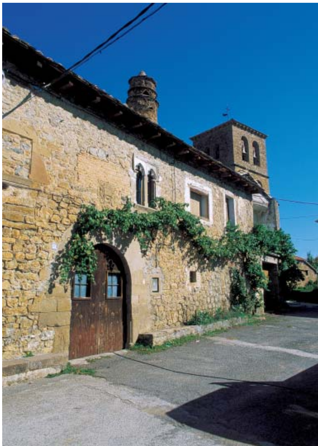
Santa Cilia. Fachada de la casa-priorato de San Juan de la Peña. Puerta de medio punto, ventana ajimezada y chimenea monumental
