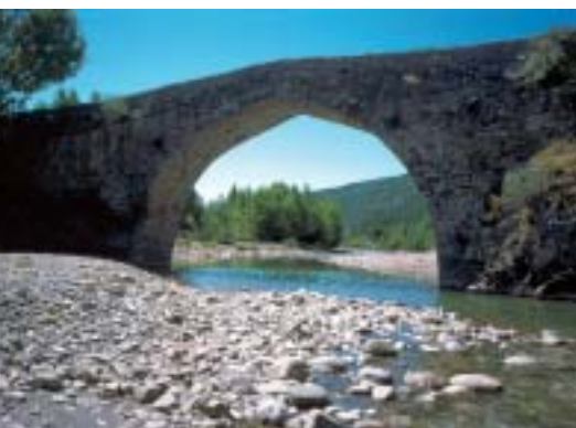
Hecho. Puente sobre el río Aragón-Subordán
