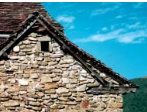
En ocasiones queda a la vista el entramado de sustentación del tejado
