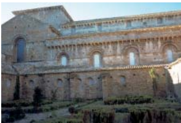
Fachada norte de la catedral de Jaca, desde el claustro
