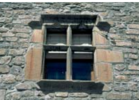
Antiguo ayuntamiento de Villanúa. Singular ejemplar de ventana tardogótica, de influencia francesa, dividido el hueco mediante un parteluz cruciforme
