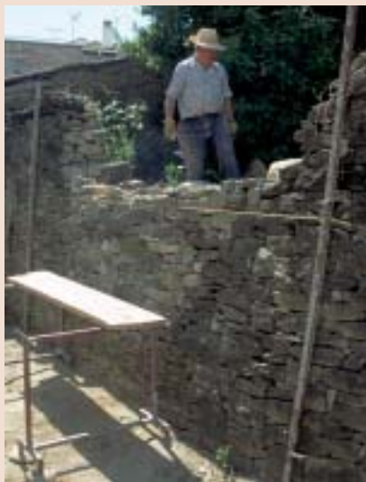
Artieda. Una actividad en desuso: reconstrucción de una pared en piedra seca al estilo tradicional (8-VI-2001)
