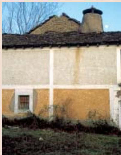
Paternoy (Bailo). Fachada de mampostería recubierta con enlucido coloreado en tres tonos
