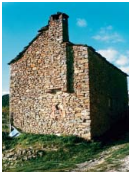
Bernués. Chimenea de planta rectangular, volada mediante ménsulas y rematada por una losa de piedra
