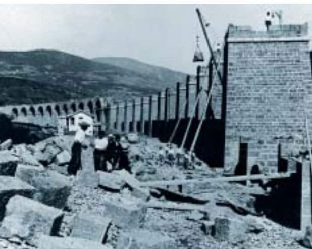
Construcción del viaducto en el tramo entre Castiello y Villanúa
