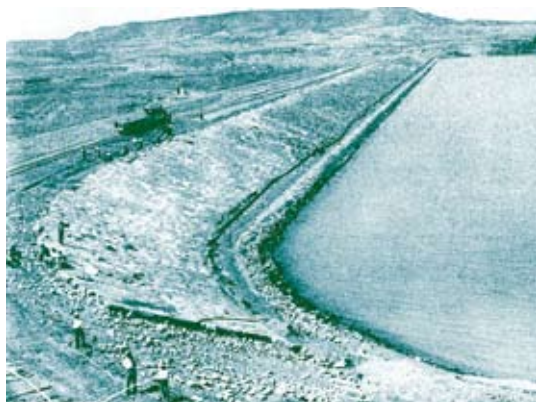
Terminando de construir la presa de La Sotonera
