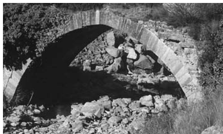
Puente del Escalar, camino de Arguís
