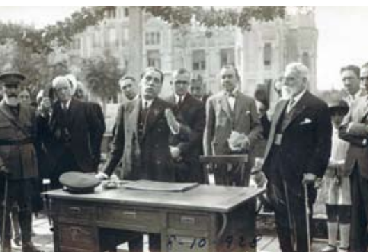
Preparando la construcción del edificio de la Delegación de Hacienda (8-10-1928). Al fondo, el casino
