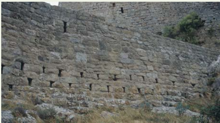
Aspilleras situadas en el paño norte de la muralla exterior, idénticas a las de Abizanda
