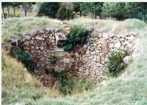
Pozo de abastecimiento de Cuello Baíl, en Santa Eulalia la Mayor
