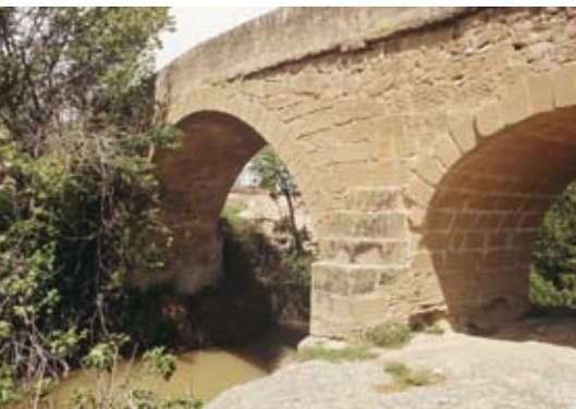
Puente de Novales
