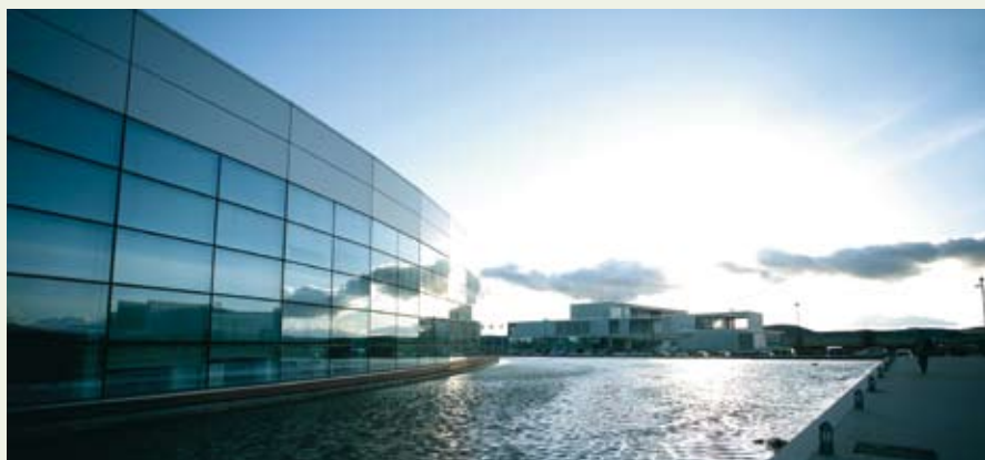
Edificios del parque
