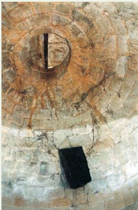
Pozo de producción de Vicién, con agujero cenital de carga y vano de acceso
