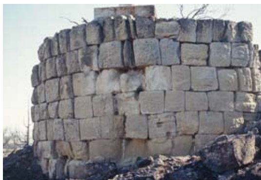
Castillo de Rosel, extraña torre circular con sillares atizonados
