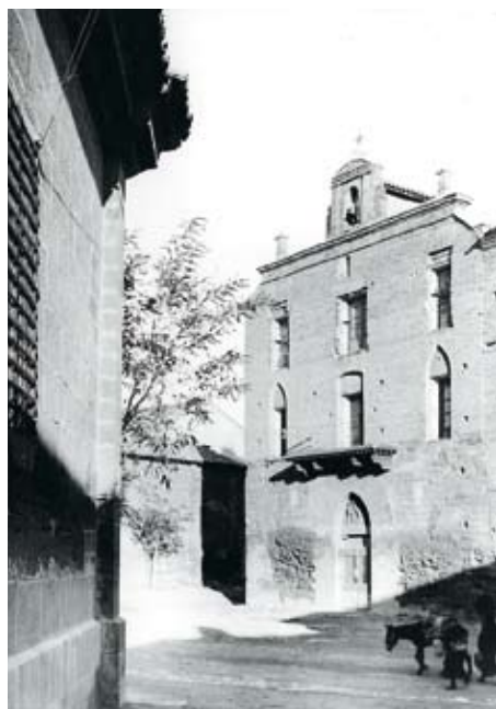
Huesca. Fachada del antiguo Hospital
