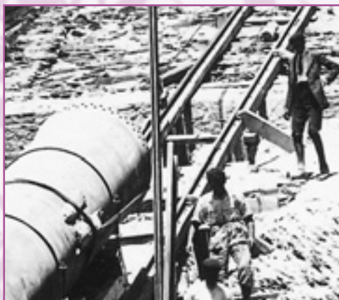
Montaje de tubos en la construcción de la central de Lafortunada (Huesca). Año 1918.
