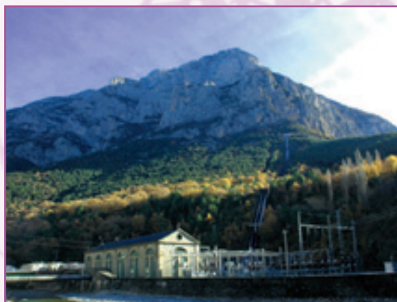
Edificio de las centrales de Lafortunada Cinca y Lafortunada Cinqueta, 42 MW y 41,4 MW.
