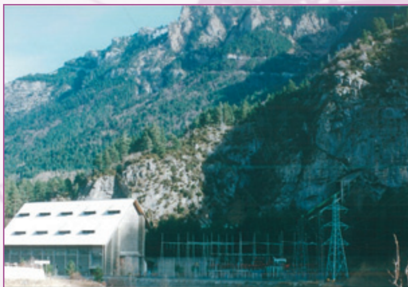
Central Hidroeléctrica de Ip en Canfranc, 84 MW (Huesca).
