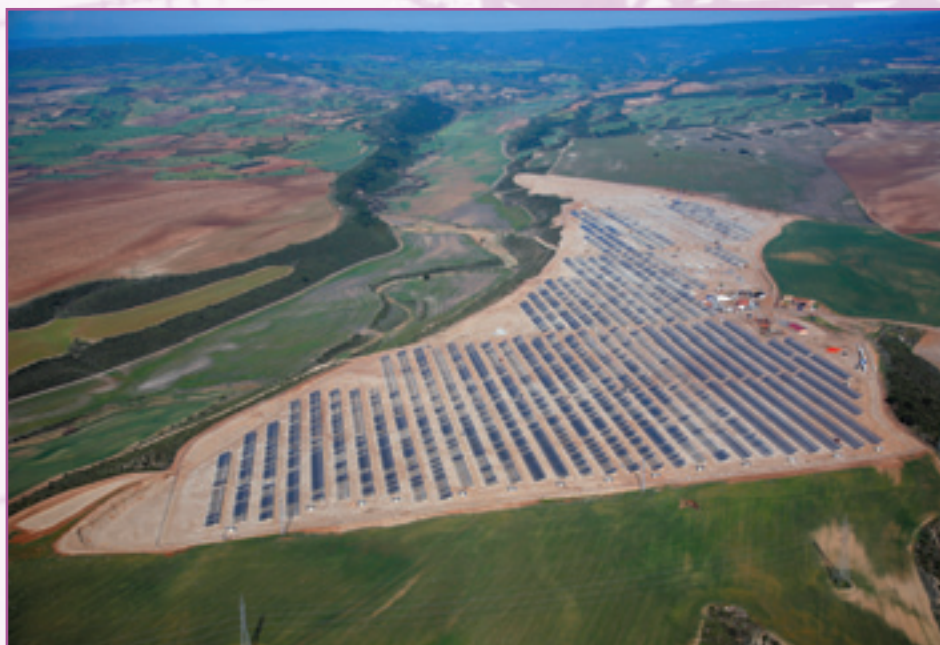
Instalación solar de 9 MW con seguidor a 1 eje. Zuera (Zaragoza).
