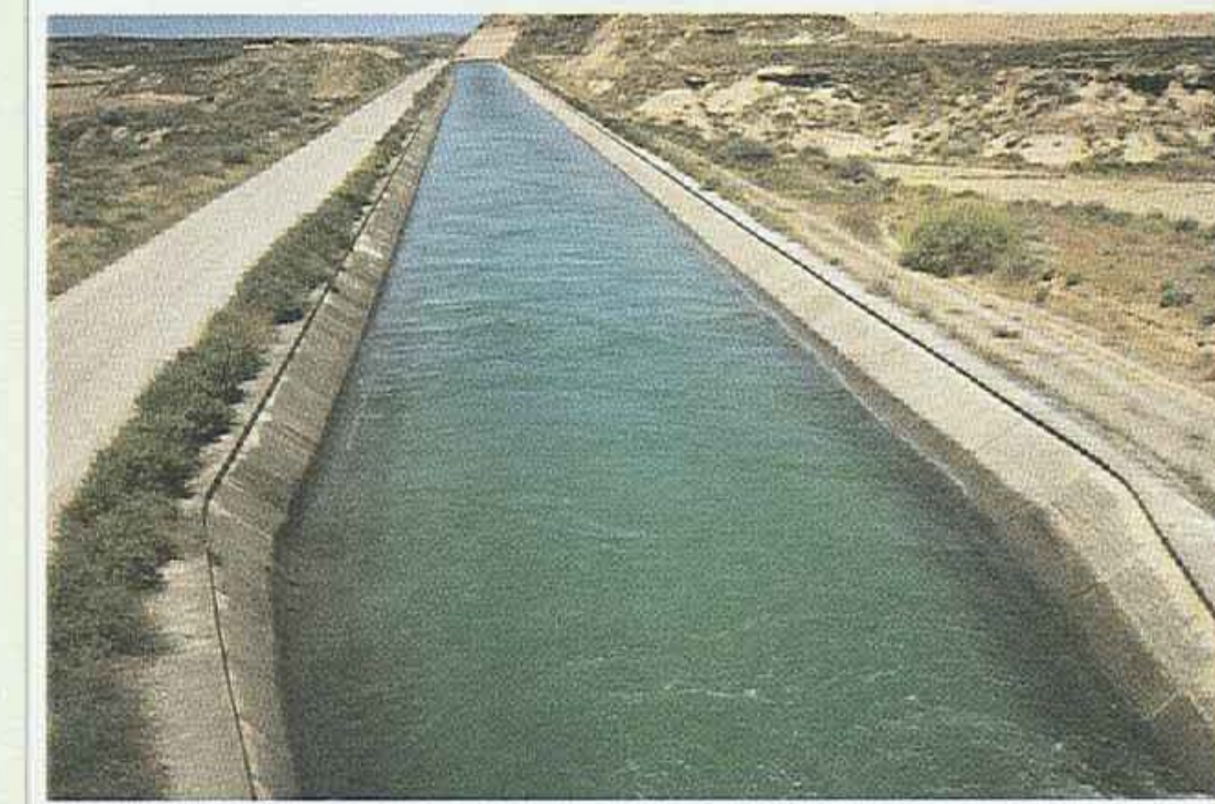
Canal del Cinca. Las obras de transformación se encuentran muy avanzadas.
