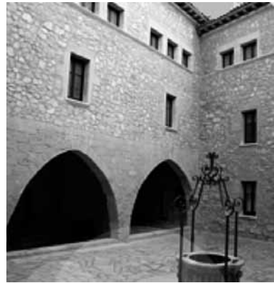
Fotografía n.º 4. Detalle del patio. Brocal del pozo.
