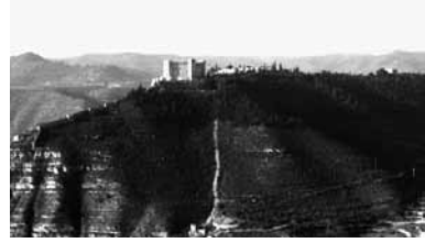
Fotografía n.º 2. Sierra del castillo. Murallas.
