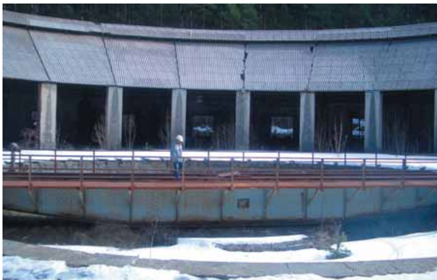
Rotonda y placa giratoria de la estación de Canfranc
