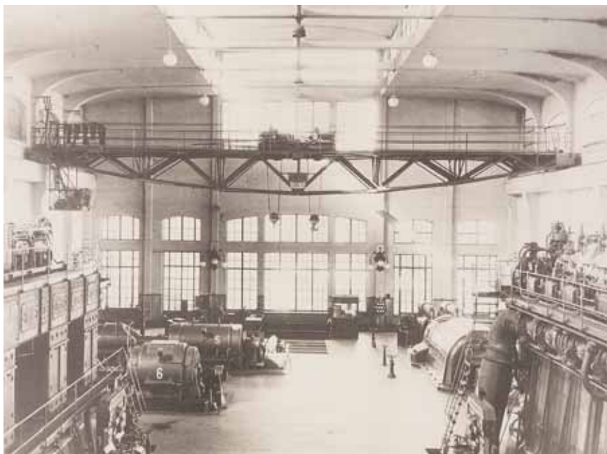
Centrale montemartini, interno della Sala Macchine, 1946
