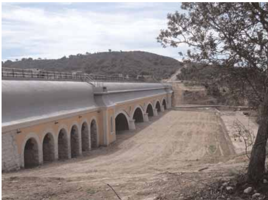
Sifón del Sosa, Canal de Aragón y Cataluña
