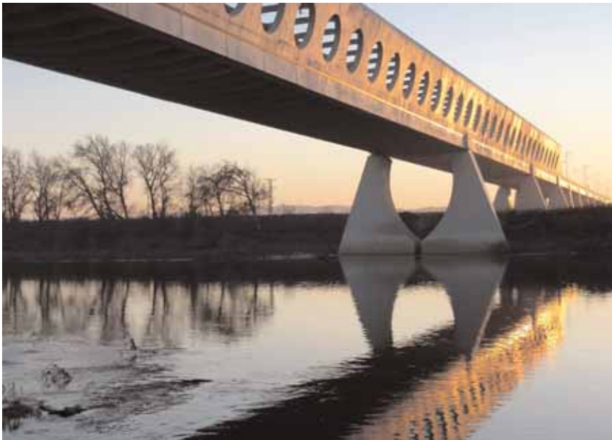
Puente del AVE en Osera de Ebro
