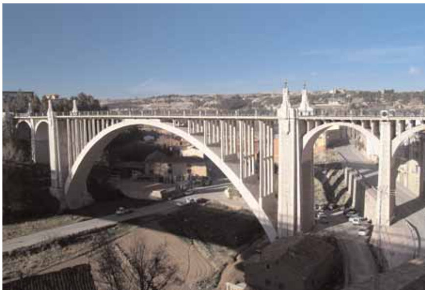
Viaducto de Teruel
