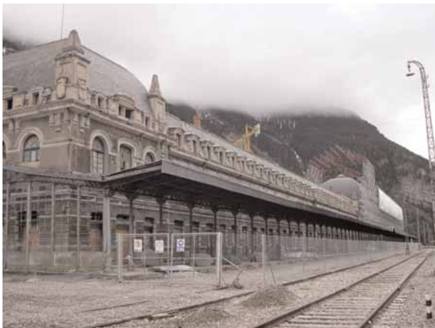
Estado actual de las obras de rehabilitación de la Estación de Canfranc
