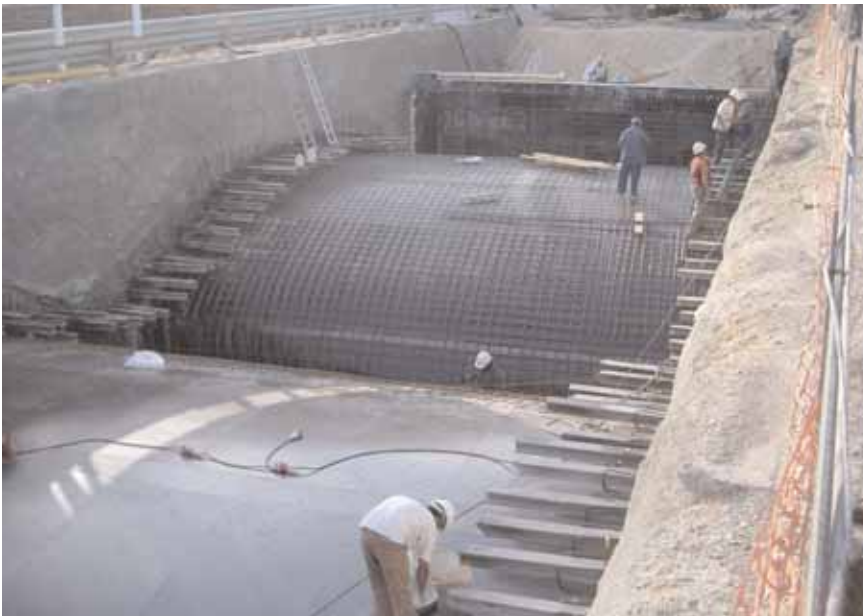
Obras de consolidación del antiguo acueducto del Canal Imperial de Aragón (Zaragoza)
