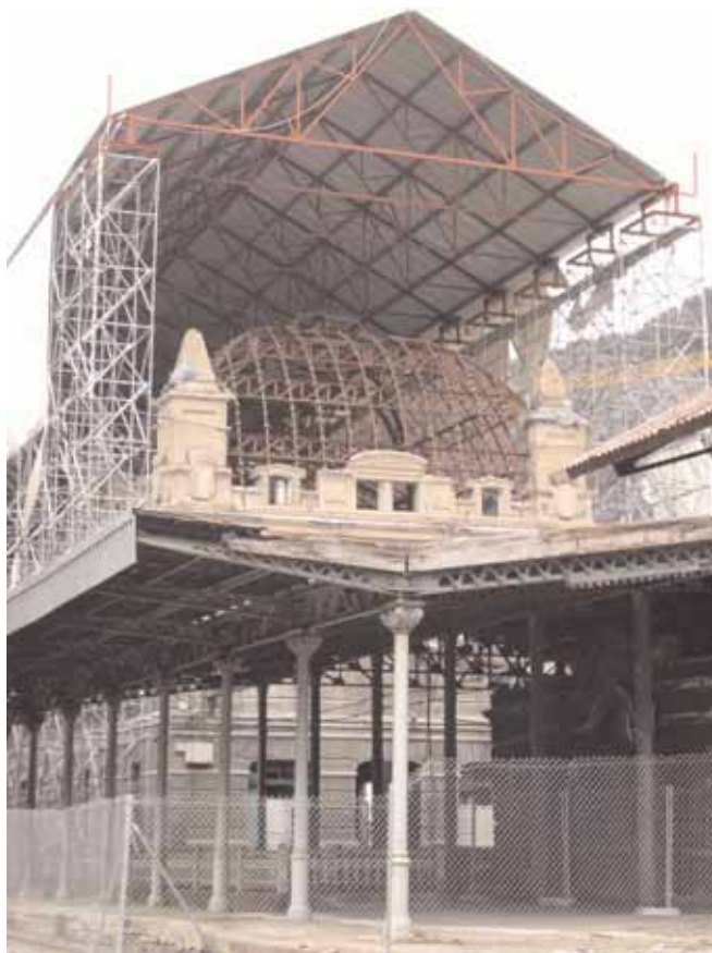
Estación Internacional de Canfranc (Huesca). Vista actual de la cubierta
