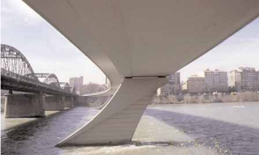
Puente de Nuestra Señora del Pilar (Zaragoza). Pilas del nuevo puente
