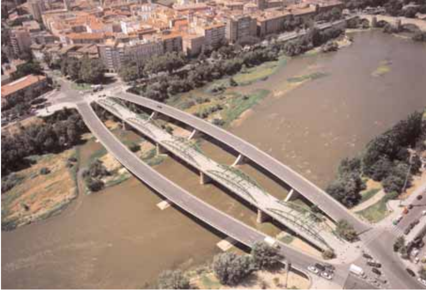
Puente de Nuestra Señora del Pilar (Zaragoza). Estado actual
