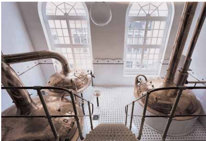
Sala de Braceado (también llamada “de cocidas”) remozada en 2001
