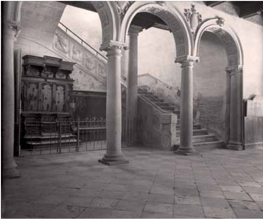
El tribunal del justicia de Huesca en el hueco de la escalera, donde permaneció hasta la Guerra Civil. En los arcos, además de la fecha (1578), se ven los medallones con llamamientos a una recta administración de la justicia. En el primer tramo de la escalera faltan el león y los bustos. (Foto: Ricardo Compairé, primera mitad del siglo xx. Fototeca de la Diputación de Huesca)
