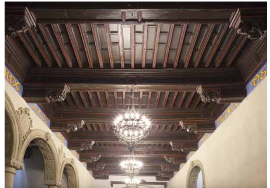
Techumbre mudéjar (1451-1456) del patio o sala baja.
