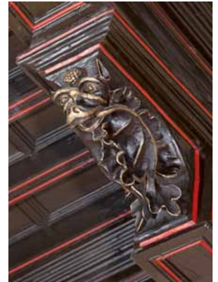
Ménsula de la jácena 6 (muro sur). Cabeza surgiendo de vegetación.
