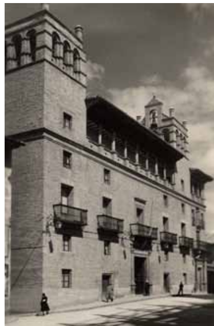
La fachada del Ayuntamiento antes y después de la intervención de Regiones Devastadas. Las rejas de la planta noble fueron sustituidas por balcones, y los balcones de la segunda planta, por ventanas. (Colección Jesús Manuel Mate Panzano)
