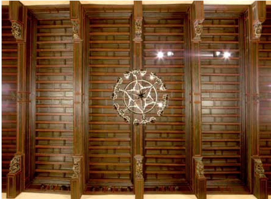
Jácenas 3 a 7 (de derecha a izquierda) de la techumbre del salón del Justicia o sala alta. (Foto: Fernando Alvira Lizano)
