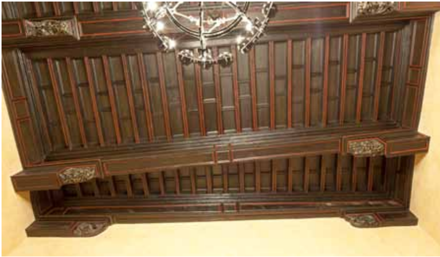
Última calle de la techumbre del salón del Justicia, de menor anchura que las demás y forma trapezoidal como resultado del derribo de la fachada original de las Casas de la Ciudad y de la construcción, algo retrasada, de la fachada actual. (Foto: Fernando Alvira Lizano)
