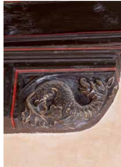
Ménsula de la jácena 1 (muro norte). Dragón.
