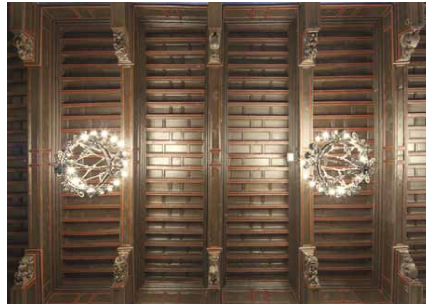
Jácenas 4 a 8 (de derecha a izquierda) de la techumbre del patio. (Fotos: Fernando Alvira Lizano)
