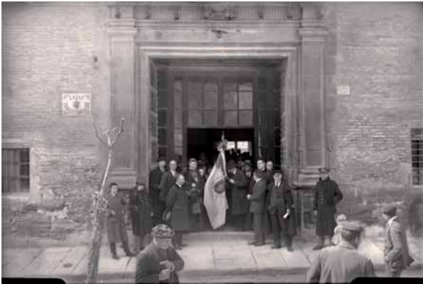
Puerta del Ayuntamiento. Destacan la mampara acristalada, luego desaparecida, la ausencia de desnivel con respecto a la plaza y el letrero en que se lee «Casas Consistoriales». (Foto: Ildefonso San Agustín, 1923-1931. Fototeca de la Diputación de Huesca)
