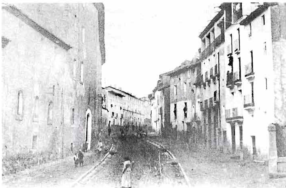
Fotografía 7. CARRETERA DE SALAS
