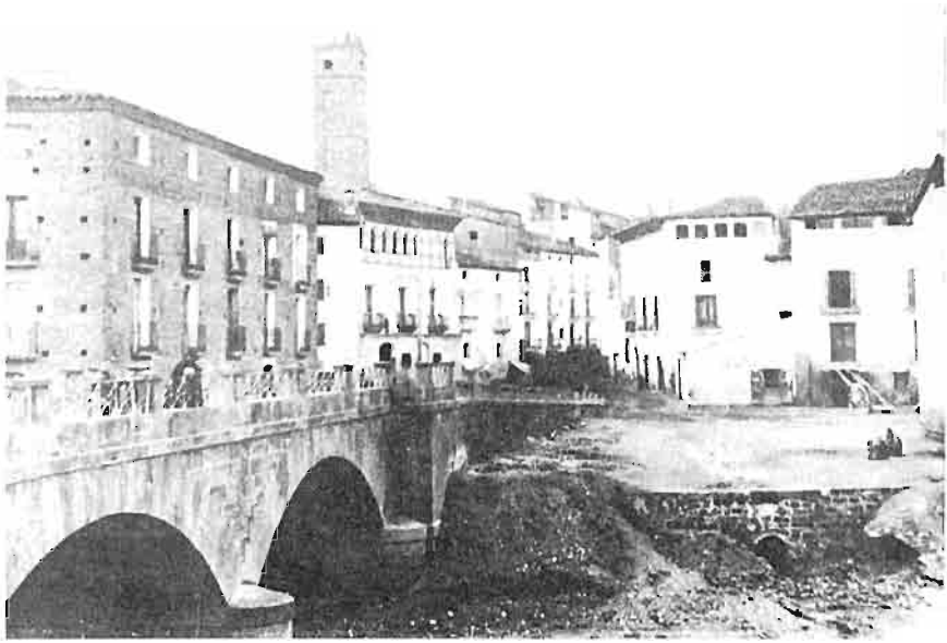
Fotografía 10. PUENTE DE LA CARRETERA DE GRAUS
