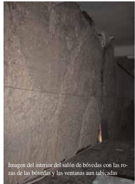
Imagen del interior del salón de bóvedas con las rozas de las bóvedas y las ventanas aun tabicadas
