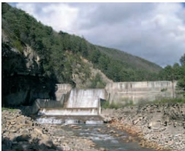
Dique de cierre de hormigón en masa y vertedero de mampostería careada en el barranco Chate o Jalle de Sarvisé (Huesca).
