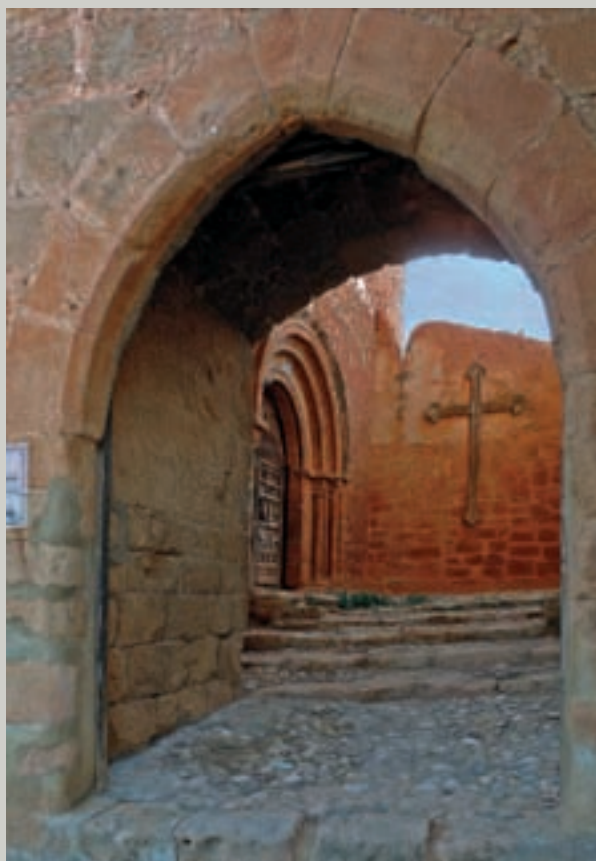
Acceso a la iglesia.
