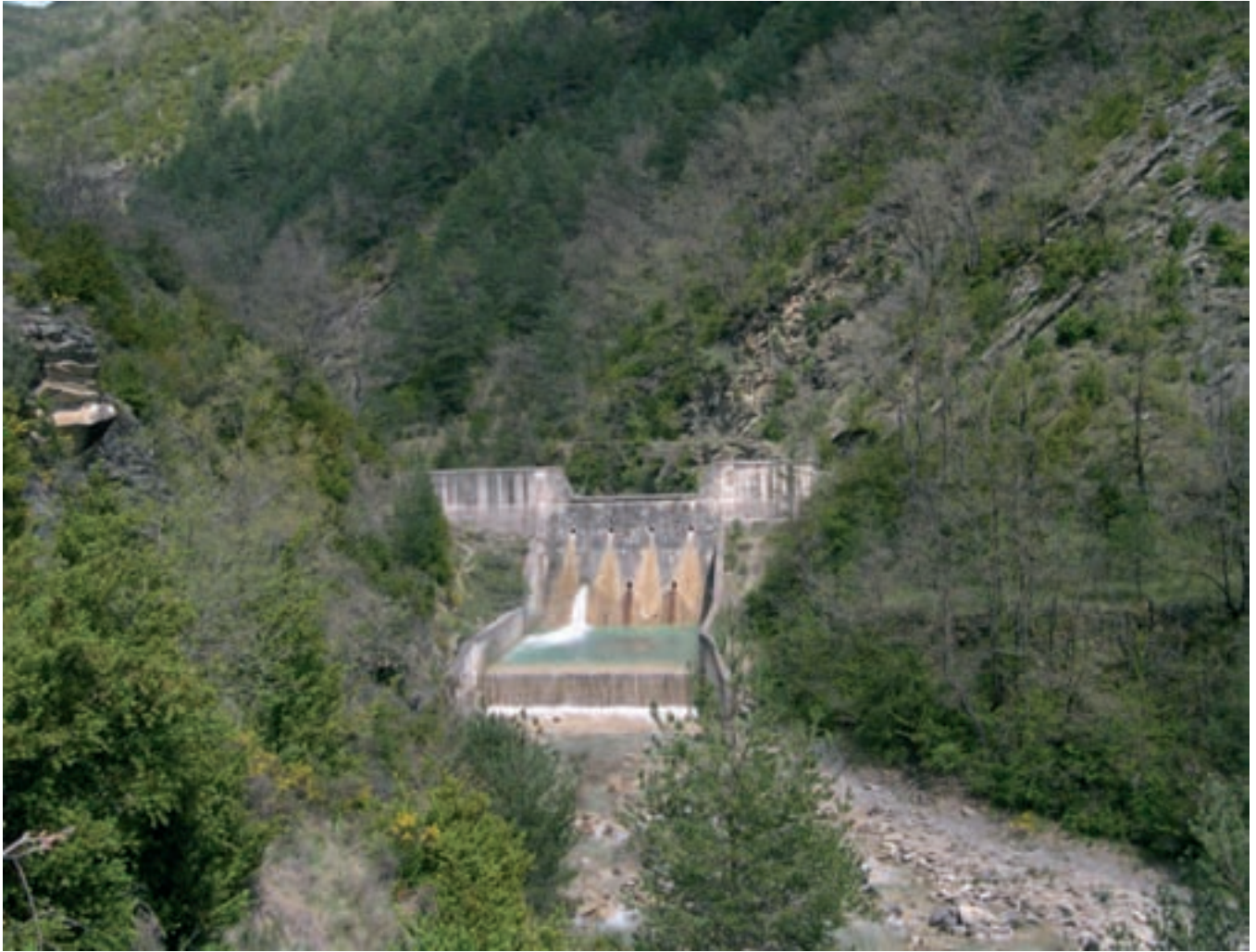
Dique de cierre en el barranco Yardo o barranco Sasé. En solana de Burgasé.
