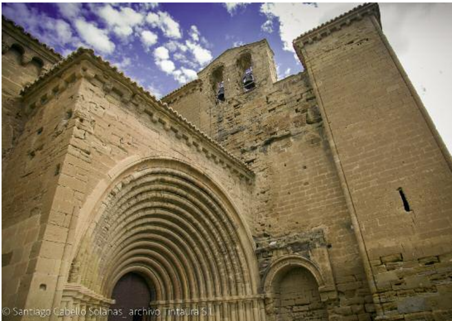
Portada sur del monasterio de Sijena. Catorce arquivoltas de medio punto con profundo abocinamiento.
