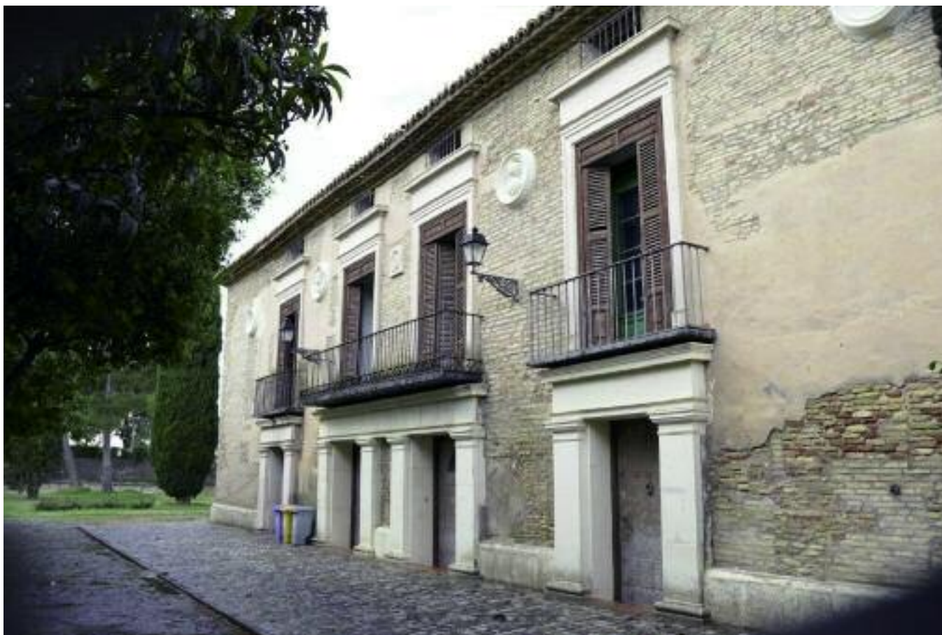
Torre de Santa Engracia. Barrio de Movera. Propiedad del Ayuntamiento de Zaragoza.
