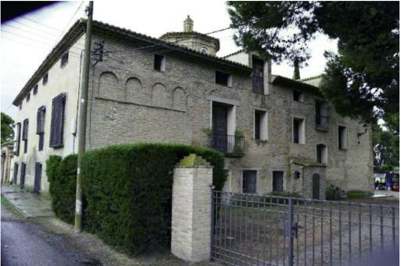
Vista posterior de la torre de Santa Engracia. Barrio de Movera. Propiedad del Ayuntamiento de Zaragoza.
