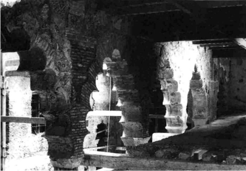
Foto 22. Entreplanta en el tramo central del pórtico norte.
