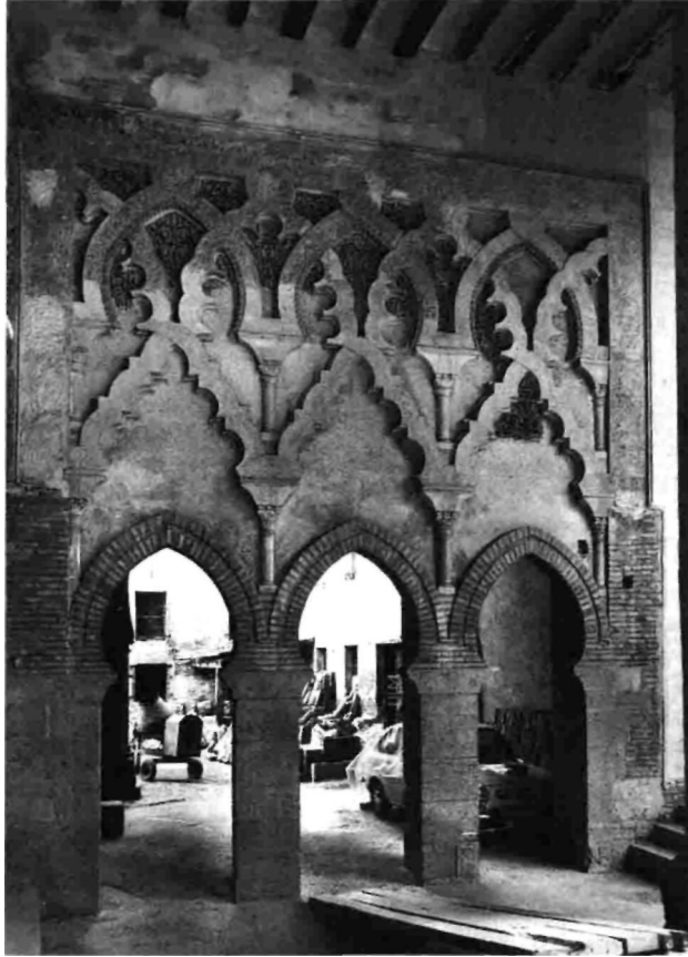
Foto 28. Primera reconstrucción de la puerta que se modificó posteriormente.
