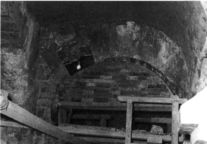
Foto 2. Torre del Homenaje. Planta baja. Reconstrucción de las arquerías.
