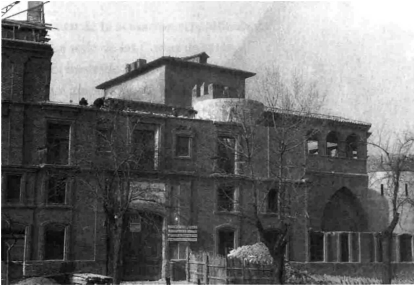
Foto 32. Demolición del cuartel y reconstrucción de la muralla árabe.
