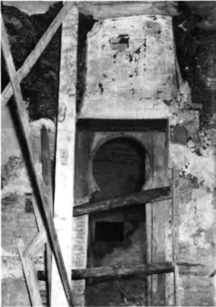
Foto 18. Torre del Homenaje. Planta baja y escalera que se había construido perforando las bóvedas.
