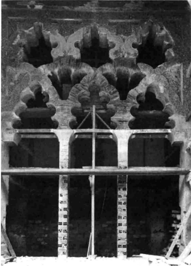
Foto 17. Restauración de la puerta del lado sur del patio de Santa Isabel.
