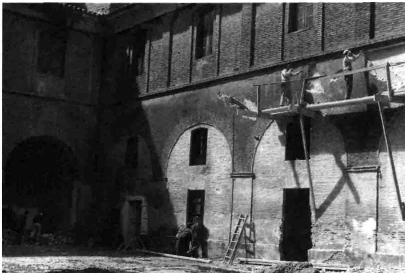
Foto 13. Aspecto del lado oeste del patio de Santa Isabel antes de la reconstrucción de los arcos góticos.
