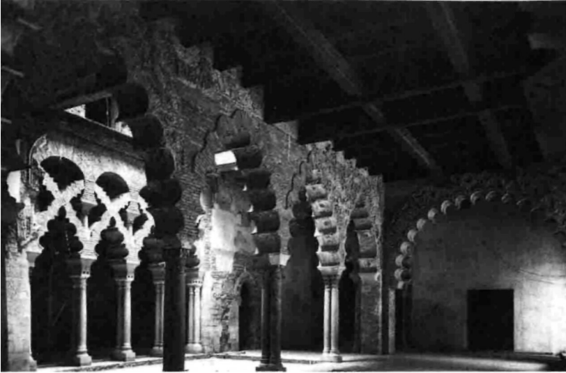
Foto 29. Conjunto de la zona norte con el arco del fondo reconstruido con un solo vano que luego se duplicó.
