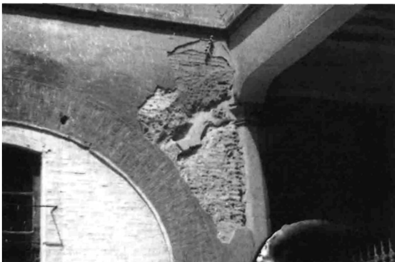
Foto 14. Descubrimiento de los arcos apuntados en el lado oeste del patio de Santa Isabel.
