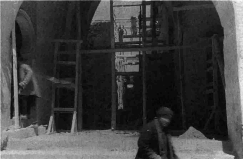
Foto 30. Arco entre el oratorio y la capilla de San Martín.
