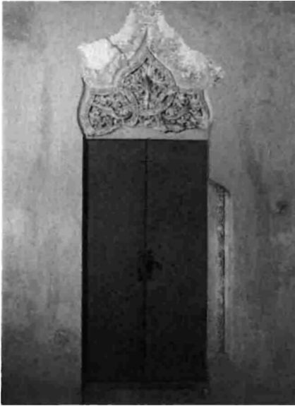
Foto 1. Salón de los Reyes Católicos. Puerta. Se restauró y completó.
