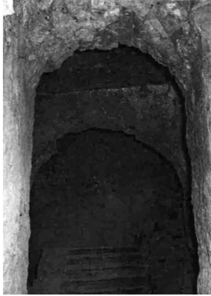
Foto 18. Torre del Homenaje. Planta baja y escalera que se había construido perforando las bóvedas.
