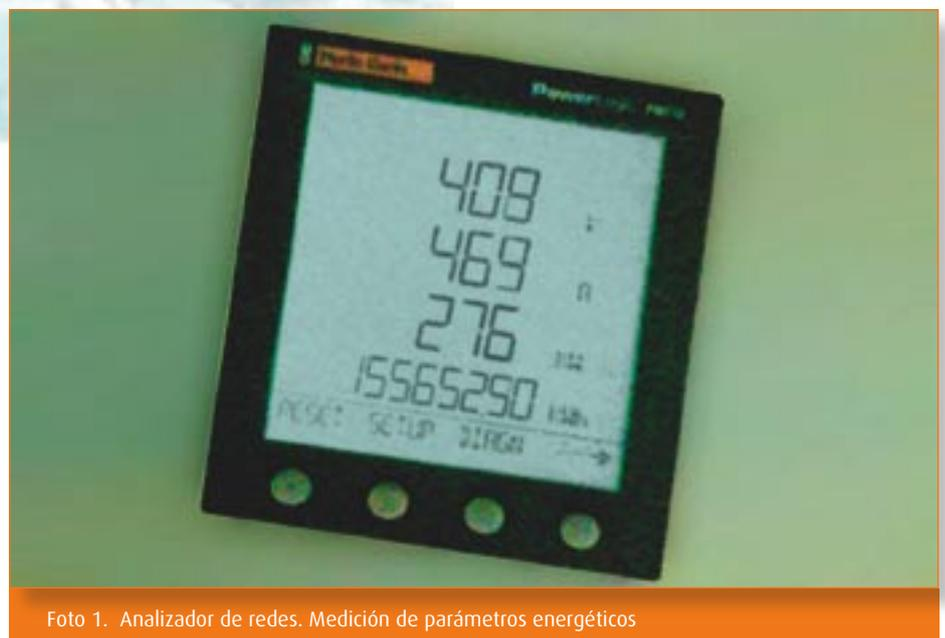
Foto 1. Analizador de redes. Medición de parámetros energéticos
