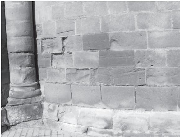
Sillares erosionados en el muro exterior del ábside central.
