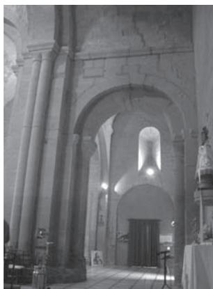
A la izquierda, cubierta abovedada en la nave central y detalle de los arcos torales que soportan la bóveda del crucero; a la derecha, vista de la nave del evangelio.
