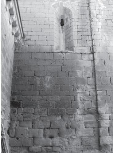
Paño del muro oeste del templo, entre el coro y el acceso a la torre. Se aprecian manchas de humedad en la parte superior y sillares deteriorados en la zona más baja.
