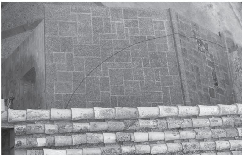
Tejado de losa de arenisca colocado sobre el coro durante la intervención de 1977 y detalle de la cubierta de la nave principal, con teja árabe.
