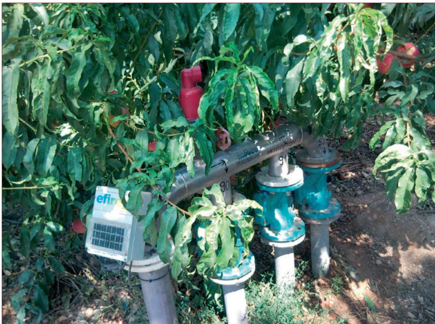
Foto 1. El dispositivo de campo se instala como un programador de riego junto a la arqueta de válvulas.
