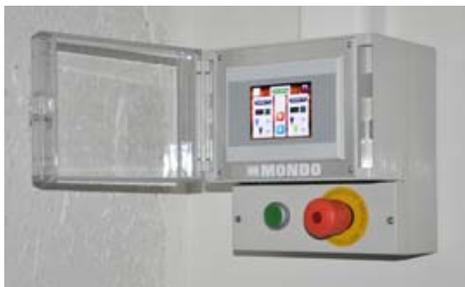
Panel de control con pantalla táctil del sistema domótico.
