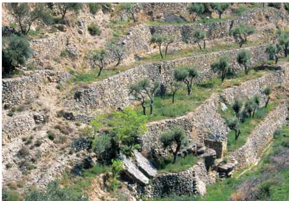
Abancalamientos en piedra seca en el barranco de Santa María en Obón
