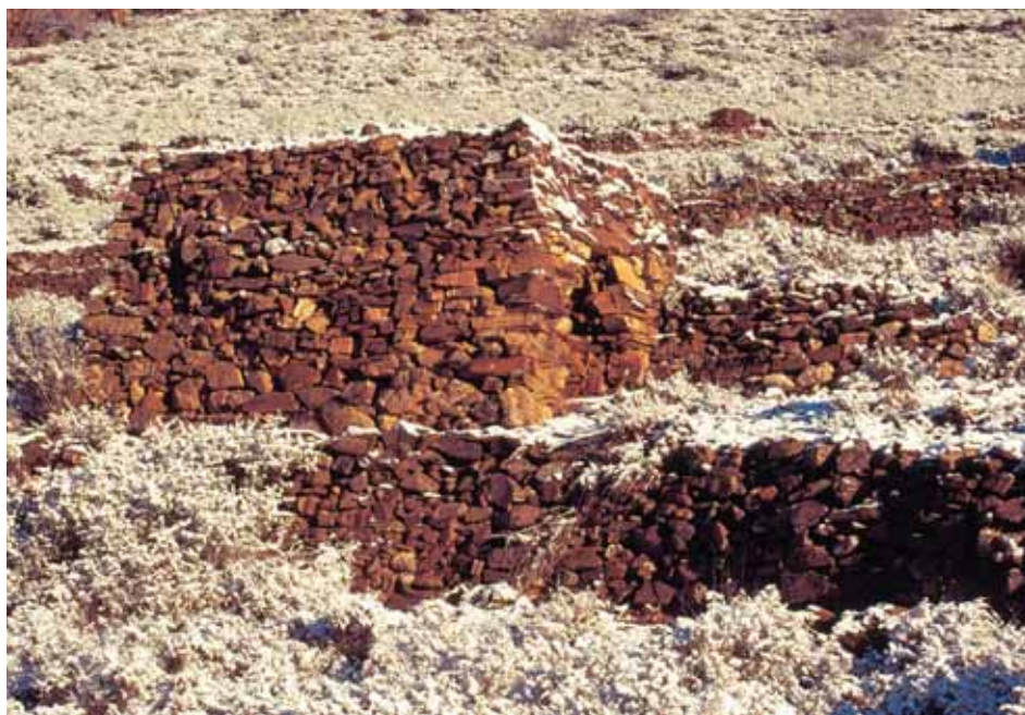
Casilla en piedra seca junto a un abancalamiento en el barranco La Juana de Montalbán
