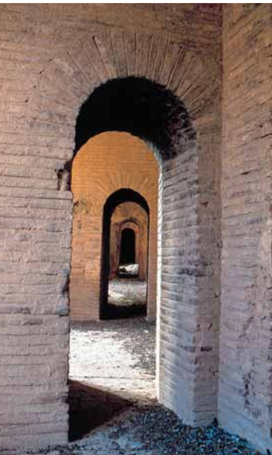
Montalbán. Paseador, ándito o tribuna de la iglesia construido por encima de las capillas laterales
