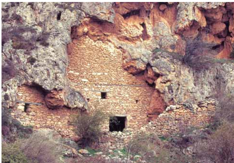
Cerramiento en piedra seca de la cueva de las Brujas en las Parras de Martín
