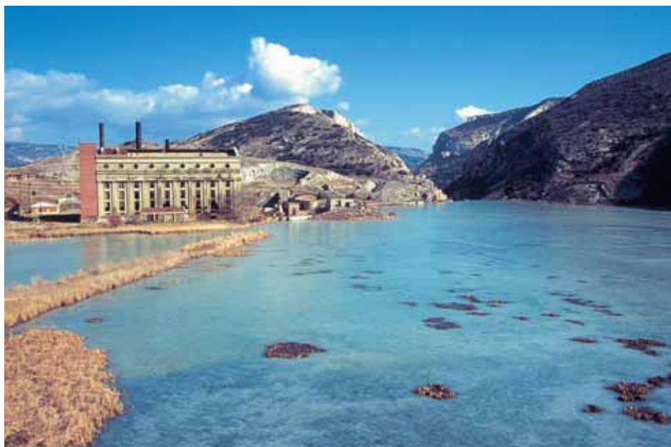
Central térmica en desuso de Aliaga
