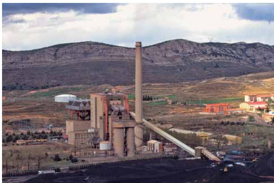
Central térmica de Escucha
