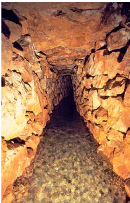
Caño subterráneo de conducción de aguas en Cuevas de Almudén
