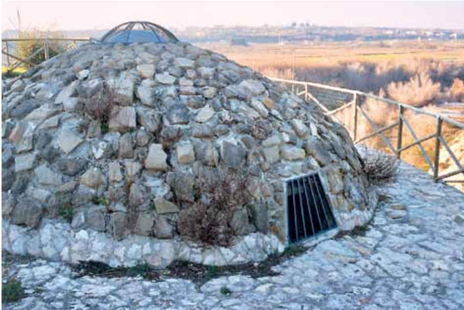
Ermita de Santiago. Remate de la bóveda después de la rehabilitación.
