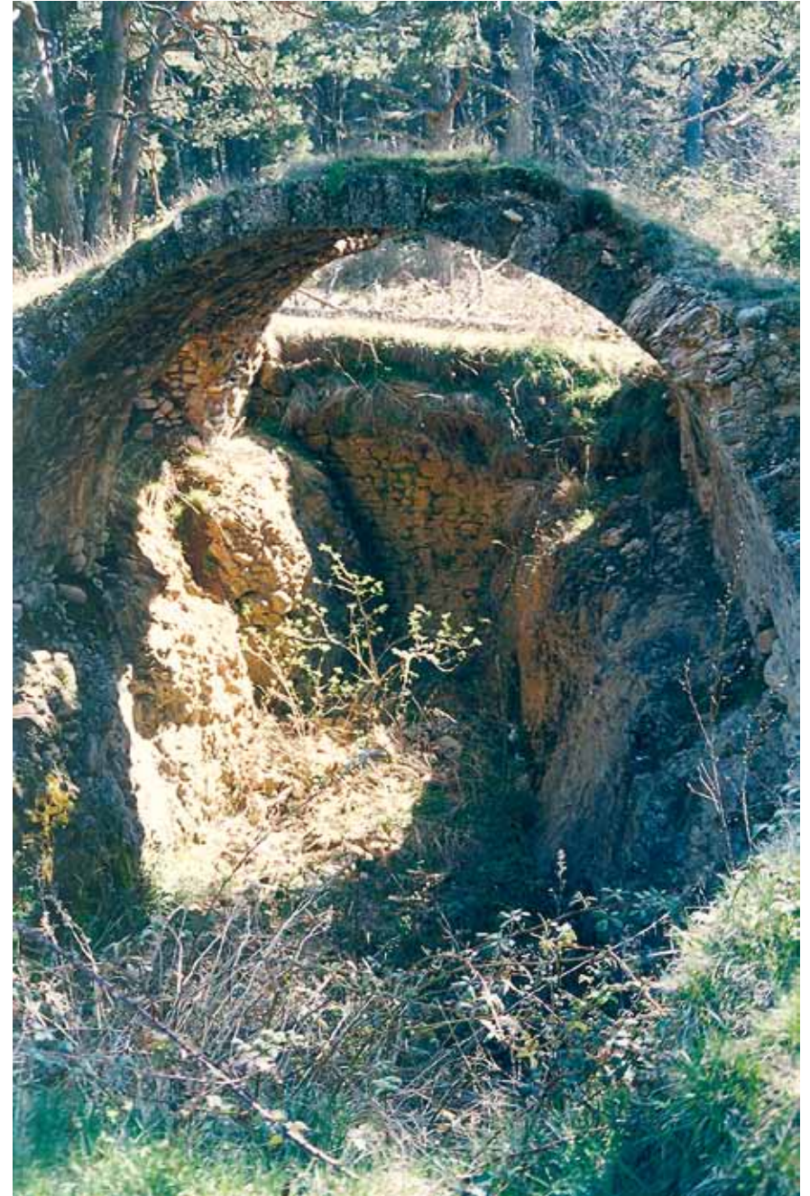
San Juan de la Peña. Paredes de piedra y ladrillo para cubrir la bóveda de esta nevera.
