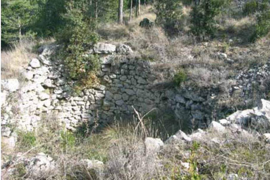
Balanz II. Al contrario que el anterior, las piedras que lo componen carecen de trabajo de cantería.
