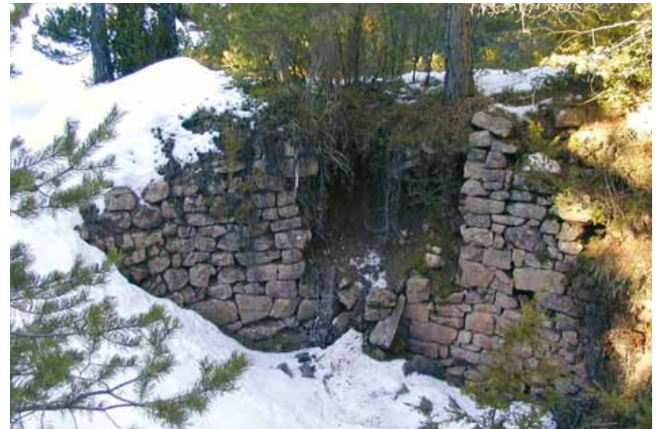
Las Calmas II. Parcialmente derruido a consecuencia de la construcción de una pista.
