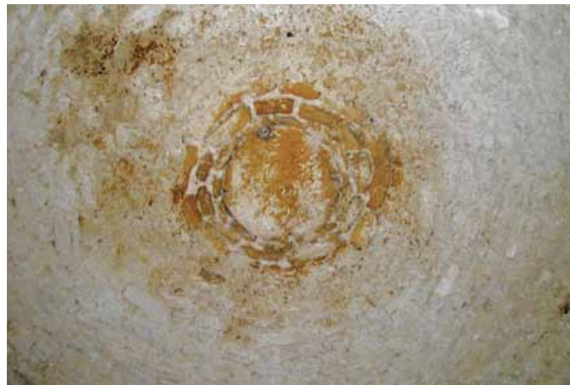
Camporrells. Original forma de cierre de la bóveda.
