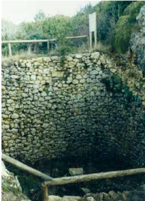
Dineretes. Gran nevera con sillares de arranque de bóveda.
