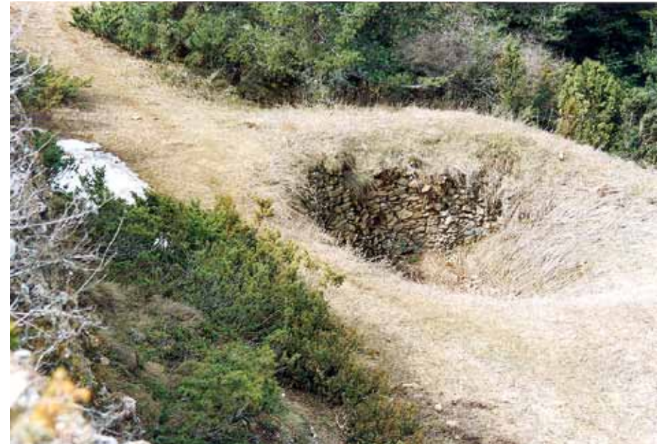
Panorámica de uno de los pozos de nieve de Oroel.
