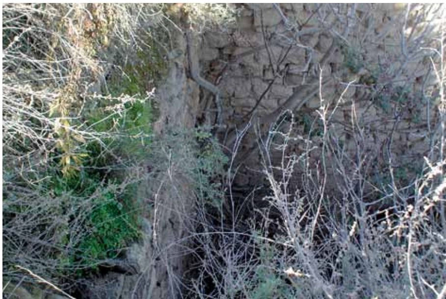
Vista de los muros del pozo de Ontiñena.
