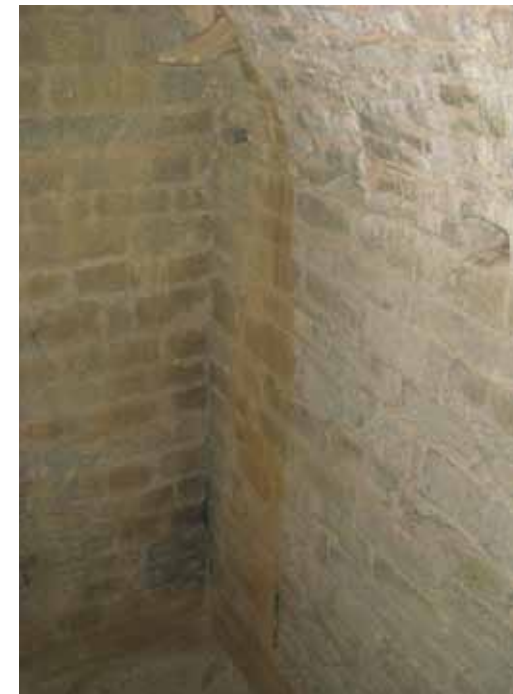
Detalle de las paredes interiores en el pozo de Graus.
