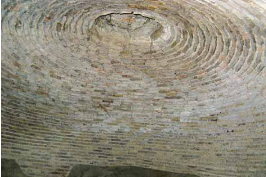
Bóveda de ladrillo para cerrar la nevera de Baells I.
