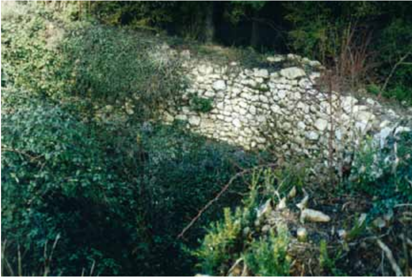
Solano de los Pozos. Trabajo en piedra seca para levantar las paredes.
