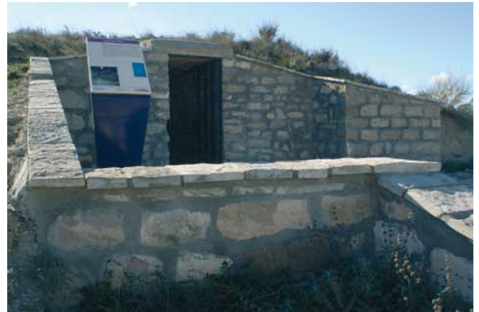
Candasnos. Vista de la entrada tras la rehabilitación.
