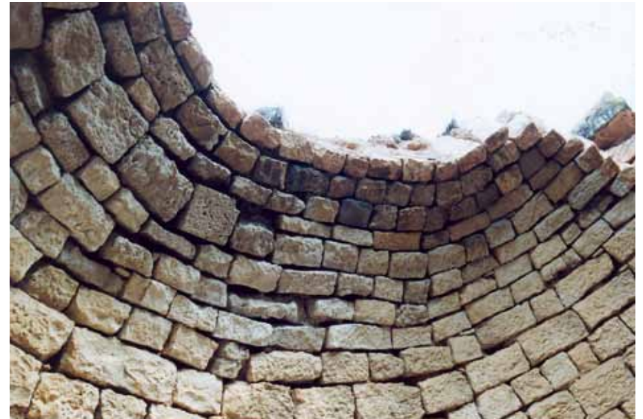
Torre Rausa. Excelente trabajo de los canteros para levantar la bóveda de sillares.
