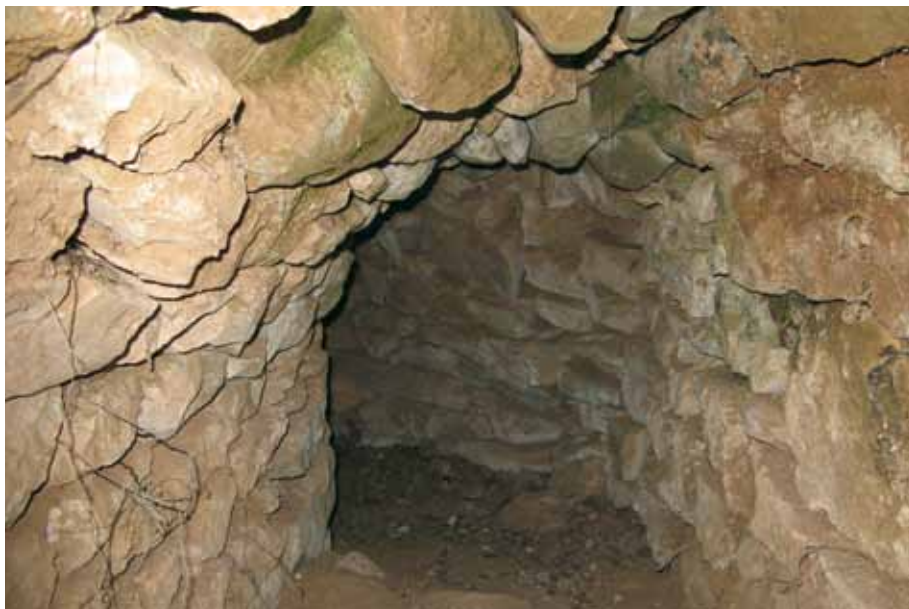
Getsemaní II. Túnel en forma de codo para evitar el paso de corrientes de aire.
