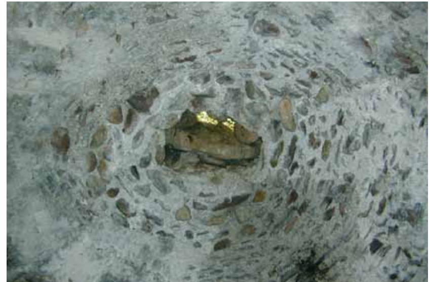
Castejón de Sos. Agujero en la parte superior para introducir la nieve.
