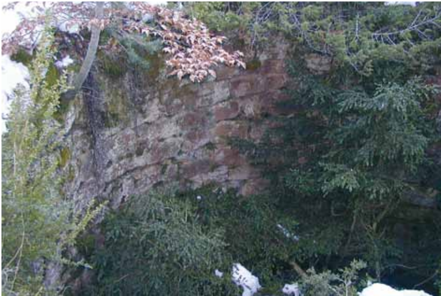
Las Calmas VII. Edificado con sillares de piedra labrada.
