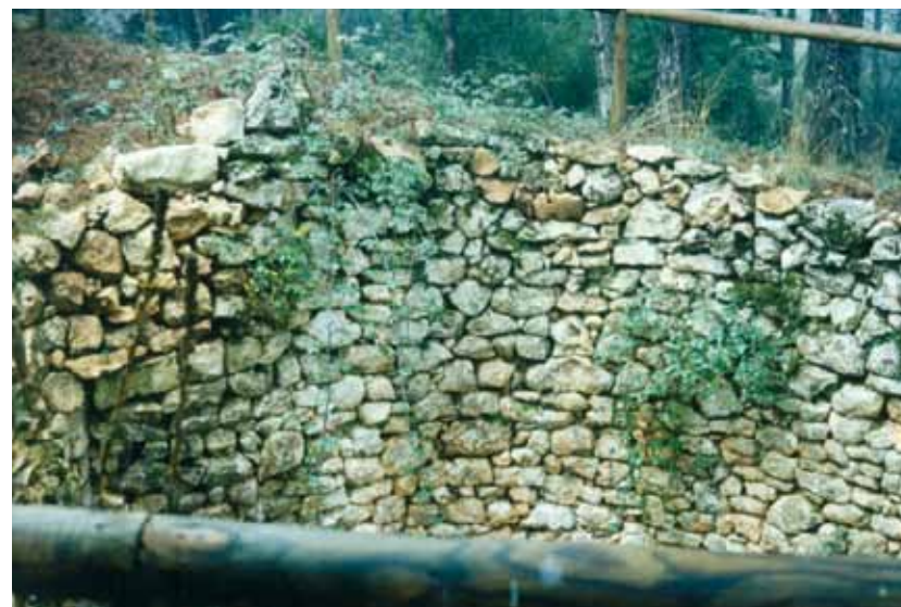
Campoluengo II. Cercana a la anterior pero de construcción menos elaborada.
