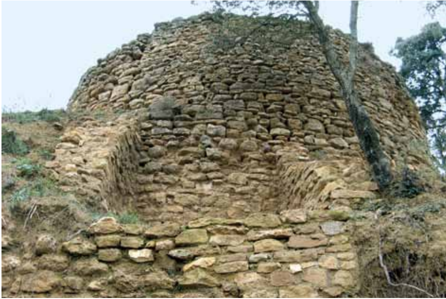
Vista exterior del pozo de Benabarre con los contrafuertes para sujetar la pared.
