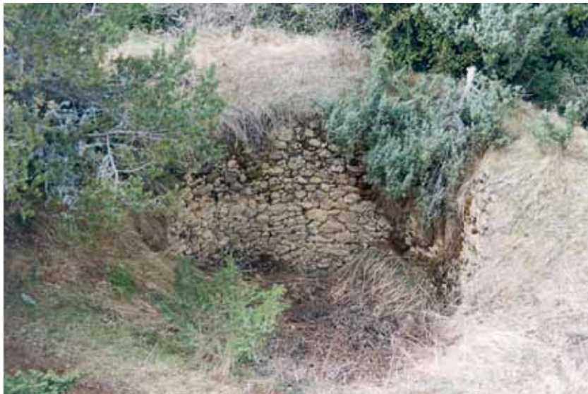
Oroel II. Sus características constructivas son similares a las del anterior.
