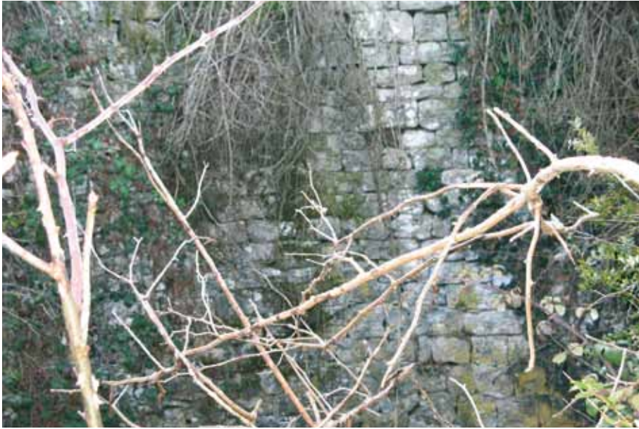
Escusaguá. Para su construcción se usaron sillares bien trabajados.
