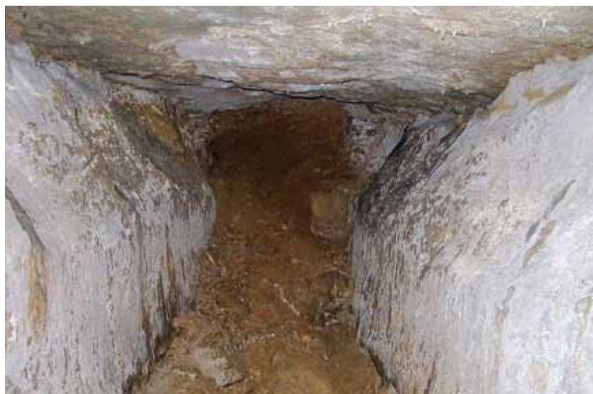
Túnel de acceso en el pozo de Monzón.
