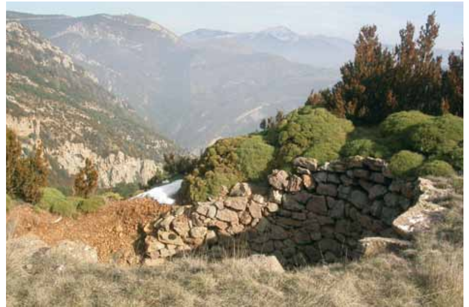
Las Calmas V. Derrumbe de parte de la construcción.
