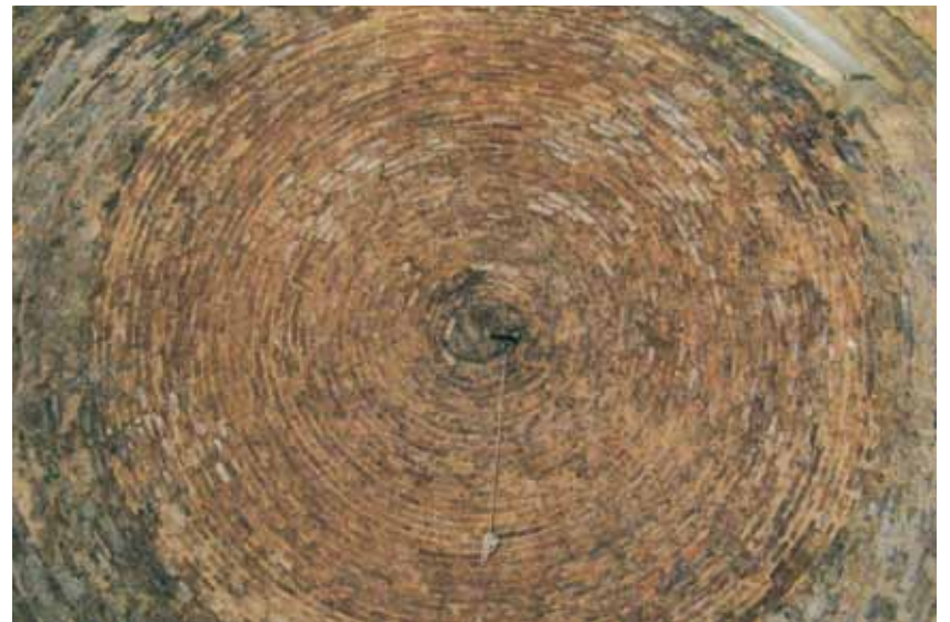
Almudévar. Bóveda actual, construida con ladrillo.
