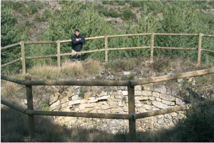
Pozo de Balanz, construido con sillares bien labrados.
