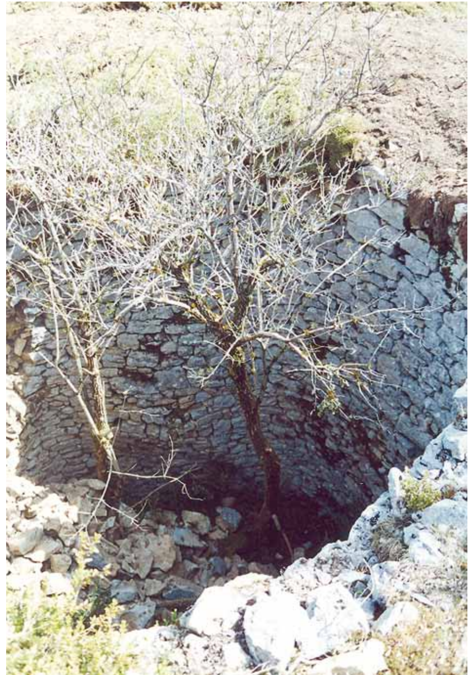
Otín II. Una escalera de piedra daba acceso al pozo, de gran capacidad.
