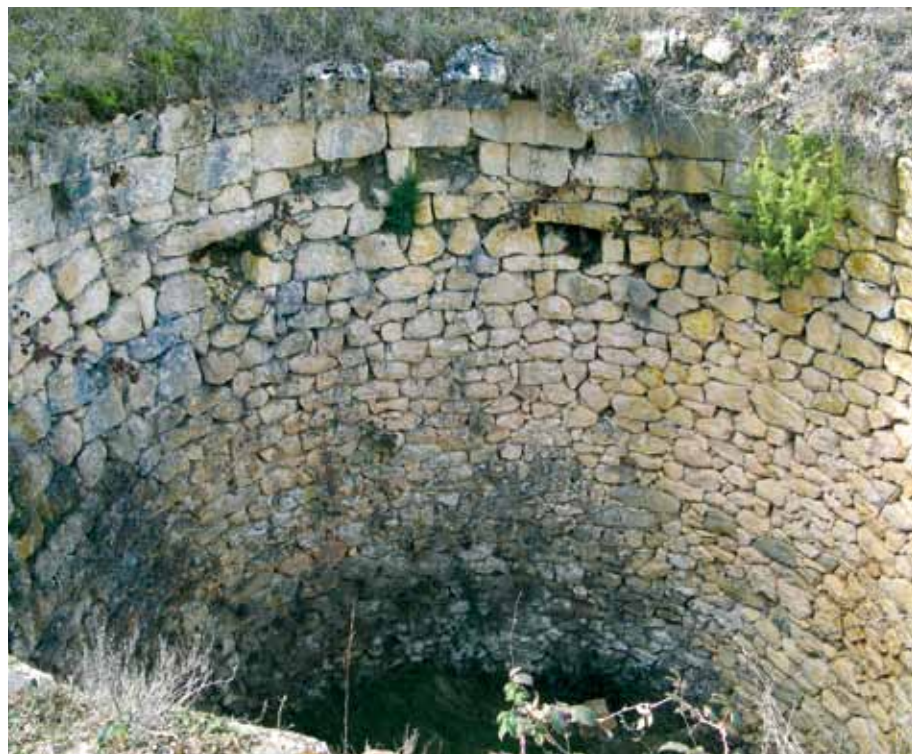
Mechinales para soporte de las vigas de madera.
