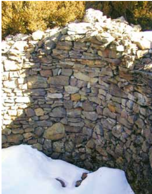
Las Calmas IV. Paredes de piedra seca con pequeños sillarejos.
