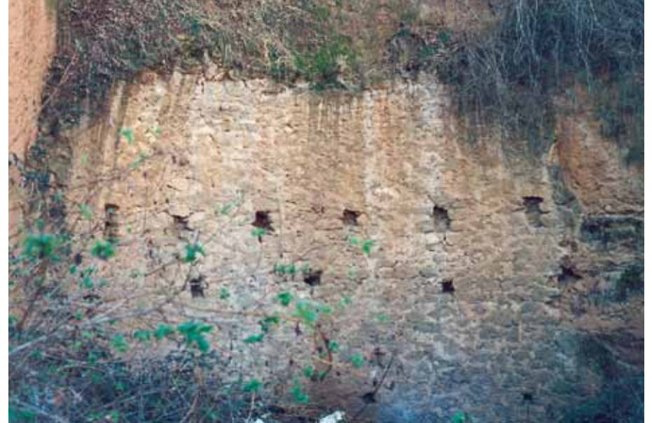
Baells II. Restos de la nevera con aberturas para colocar vigas de madera.
