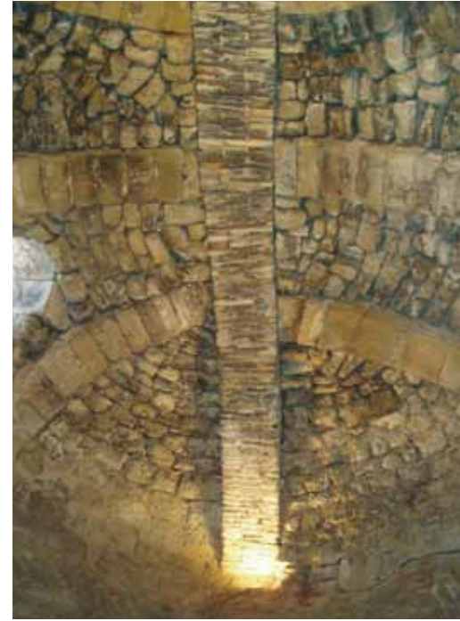
Salillas. Bóveda de ladrillo, sillar y piedra sin labrar.
