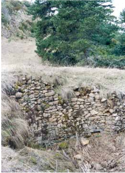
Oroel I, construido con piedras sin labrar.
