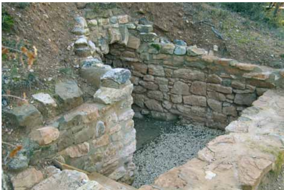
Getsemaní III. Puerta de acceso tras las obras de limpieza y rehabilitación.
