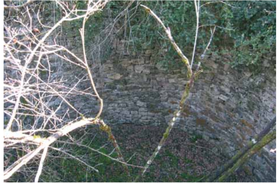
Pozo de Fanlo. Paredes de buena factura.
