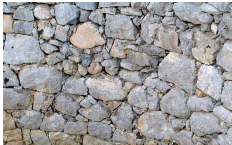
Sillarejos de gran tamaño para levantar el pozo de nieve de Las Planas.
