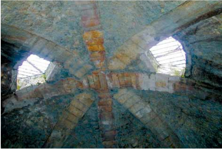
Bóveda del pozo de Campoluengo I.
