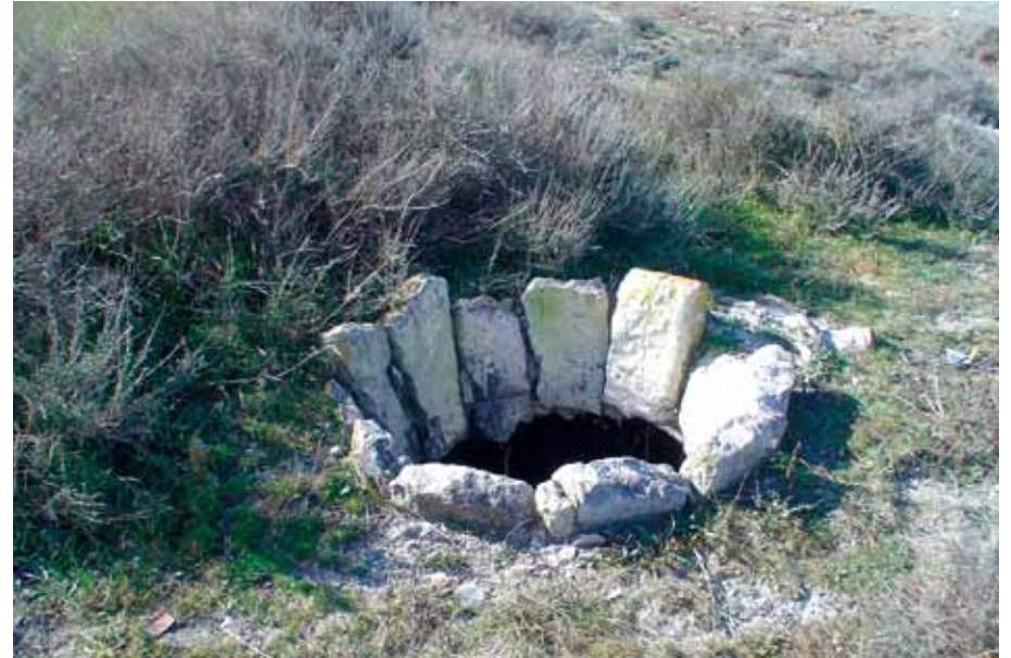
Valfarta. Abertura en forma de embudo para facilitar el llenado.
