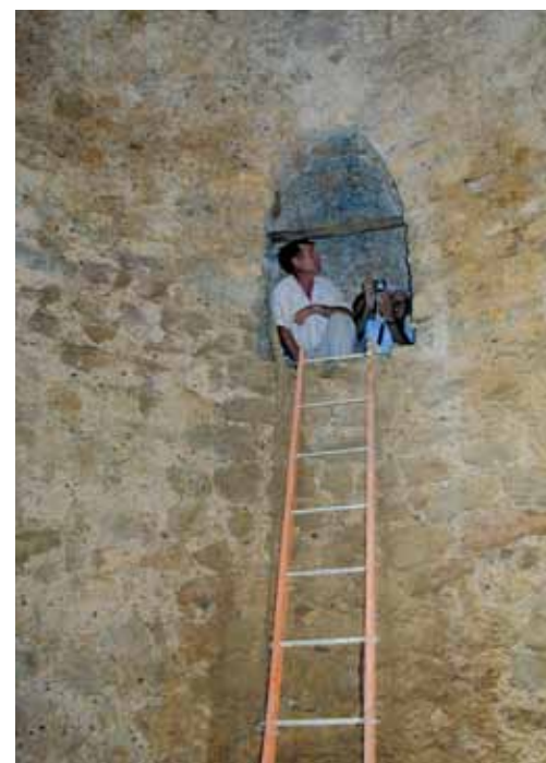
Baldellou. Puerta elevada a la que se llega por un pasadizo.
