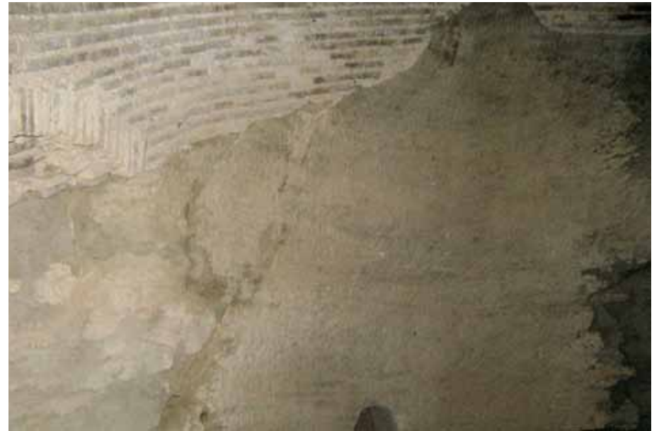
Baells I. Excavado en arenisca. Hay restos de paredes y techo de ladrillos unidos con argamasa.
