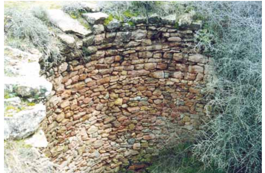
Mata Menuda I, compuesto por paredes en piedra seca.
