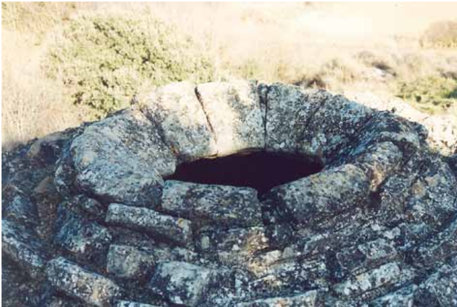
Calasanz. Original abertura en forma de embudo para introducir la nieve.
