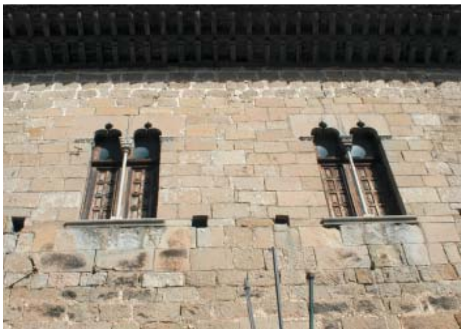
Detalle de la fachada del ayuntamiento de Puertomingalvo
