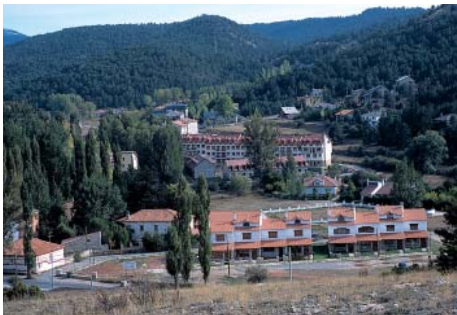
Nuevas urbanizaciones turísticas en Alcalá de la Selva
