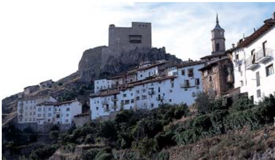
El restaurado castillo de Alcalá de la Selva, dominando el caserío
