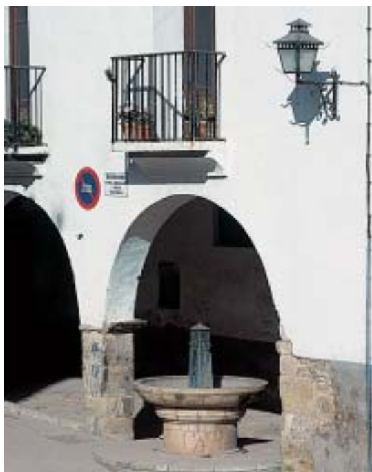
Ayuntamiento de Olba. Detalle de la fachada
