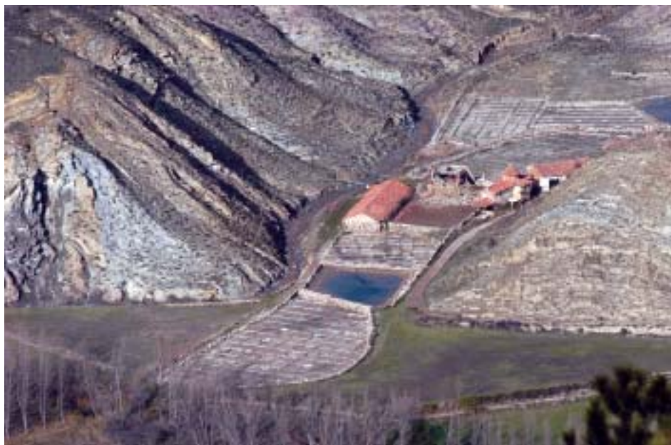
Salinas de Arcos, conjunto arquitectónico y etnológico de excepcional interés, merecedor de una rehabilitación integral
