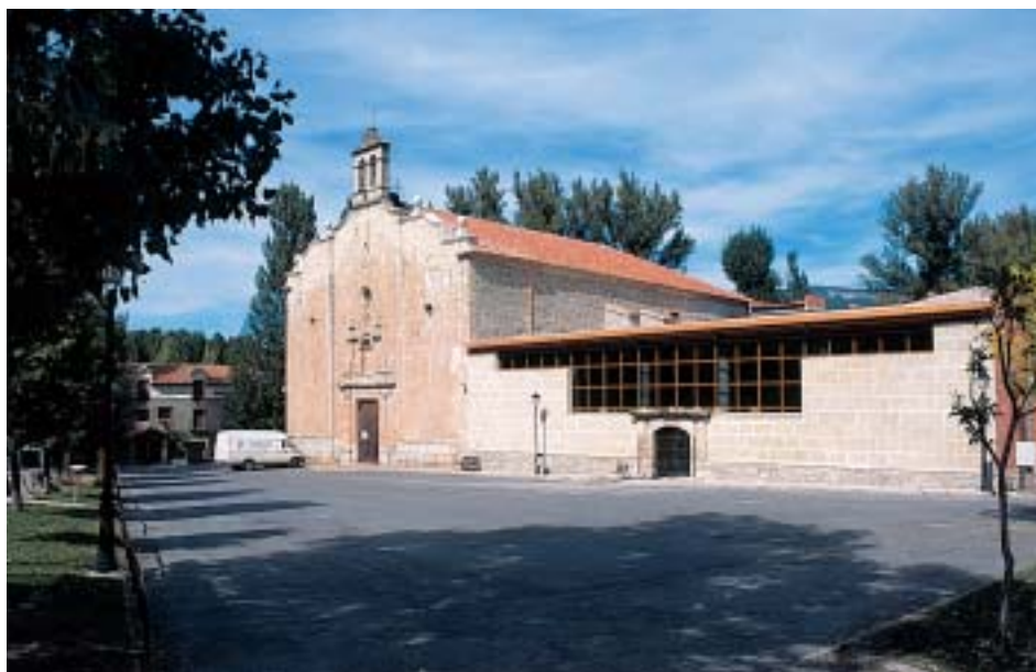
Junto al santuario de la Virgen de la Vega, el centro de interpretación de la Sierra de Gúdar se está construyendo con apoyo externo
