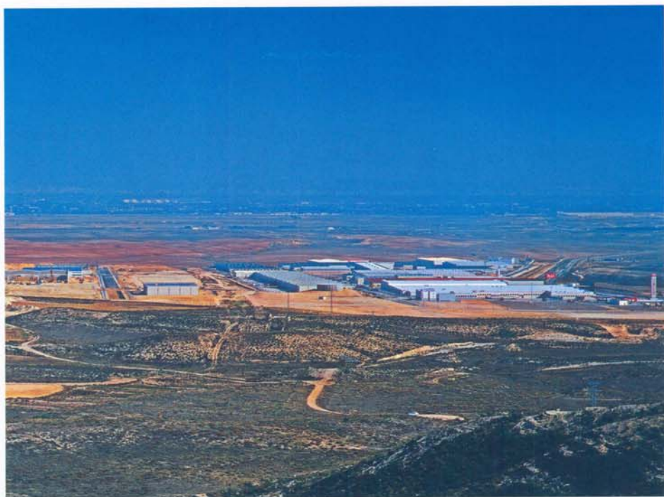
La Muela. Polígono industrial Centrovía
