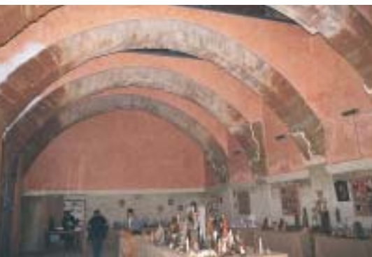
La Sala Capitular tras su rehabilitación
