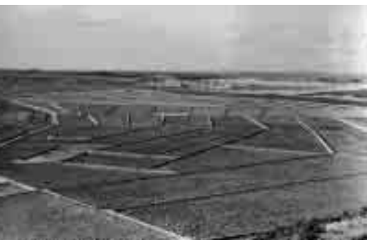
Tierras niveladas en el tercer tramo del canal de Monegros, en el área de influencia del nuevo poblado de Frula
