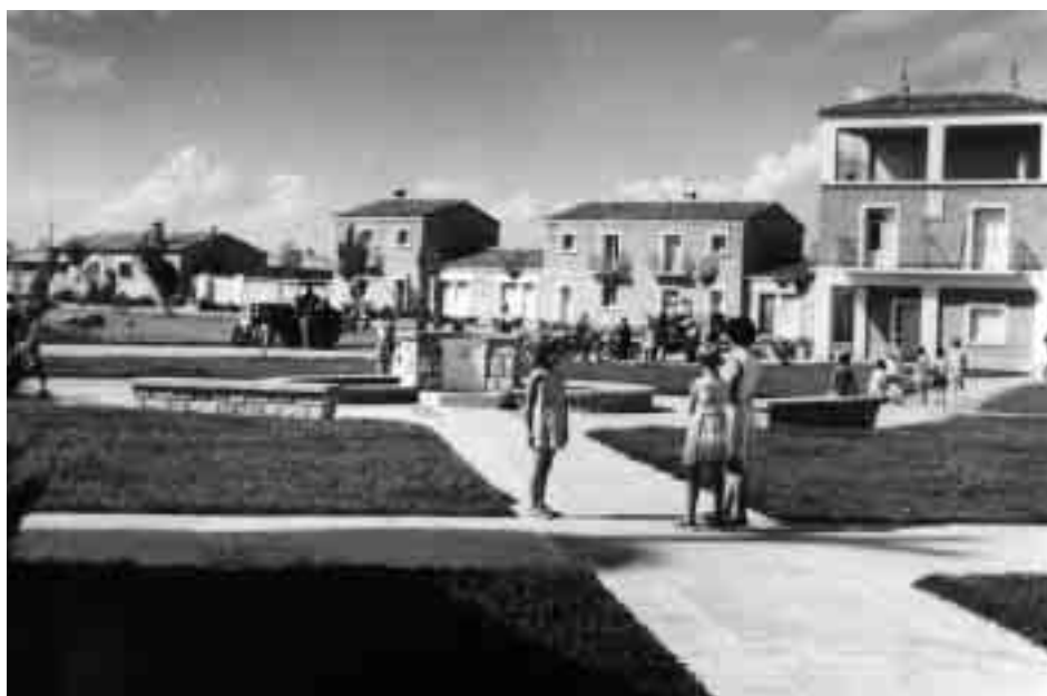
Plaza del nuevo poblado de Valfonda de Santa Ana, en el segundo tramo del canal de Monegros
