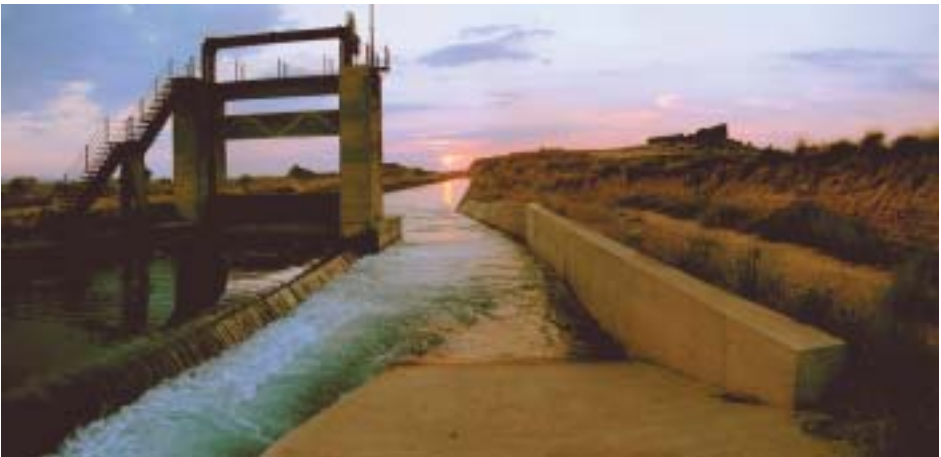
Compuerta en el Canal del Cinca
