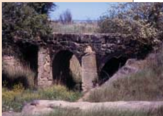
Acueducto de Sangarrén
