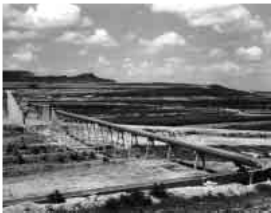
Acueducto correspondiente al segundo tramo del Canal de Monegros
