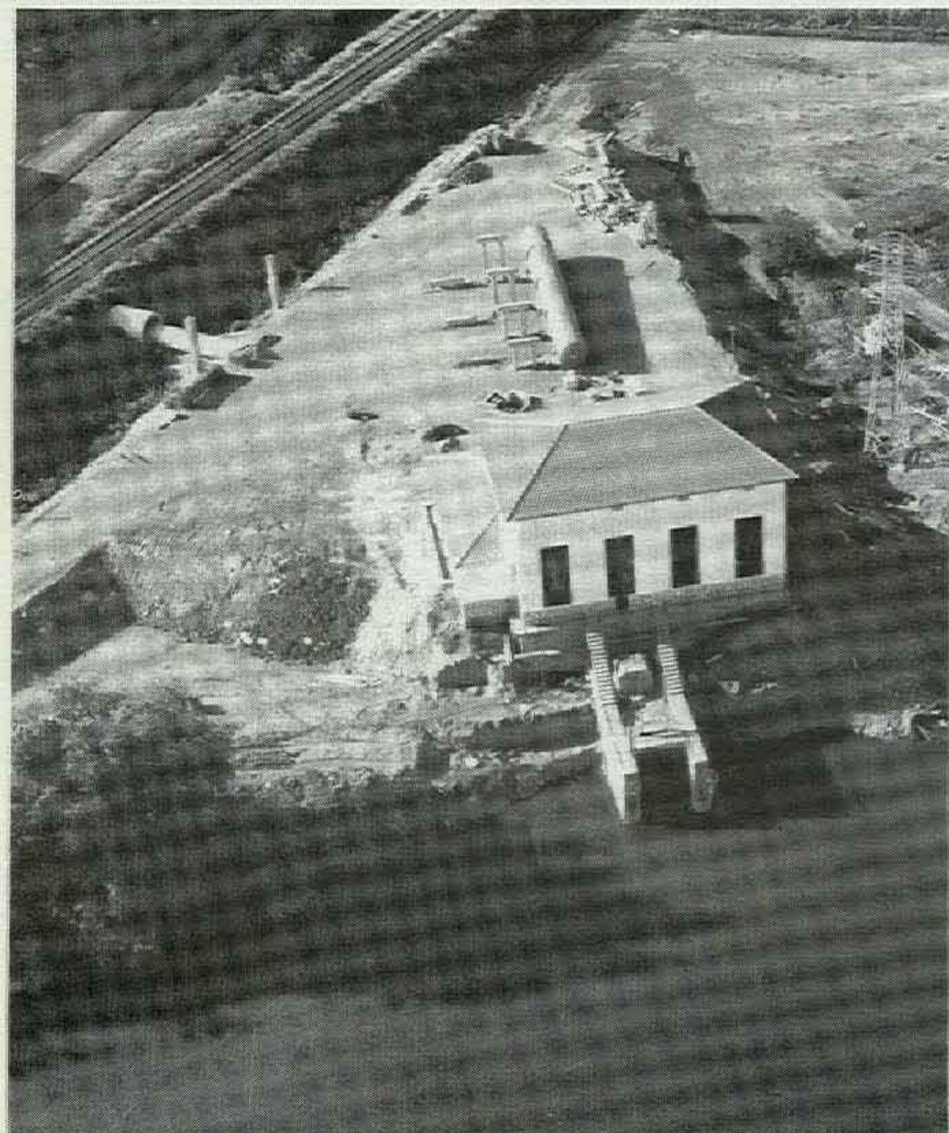
La elevación del agua del Ebro hasta 121 metros de altura, se hace con seis grupos de 1.500 CV y un caudal de 600 litros por segundo cada uno.
