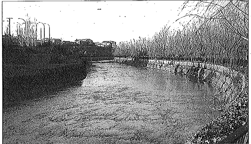
Zona del Arba de Biel cuyo encauzamiento se ha solicitado.
