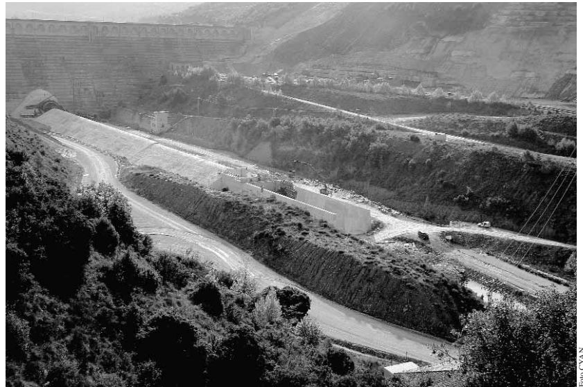
Obras de recrecimiento de Yesa
