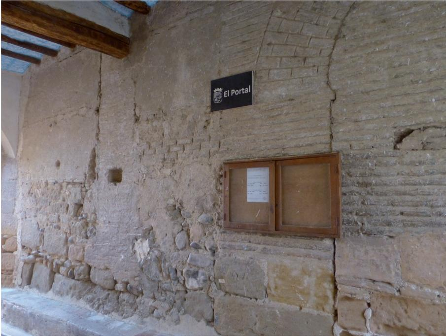
*Imagen nº 6. Muro oeste de la iglesia sobre el que descansa el coro y se levanta la torre (Foto: Ánchel Conte)*
