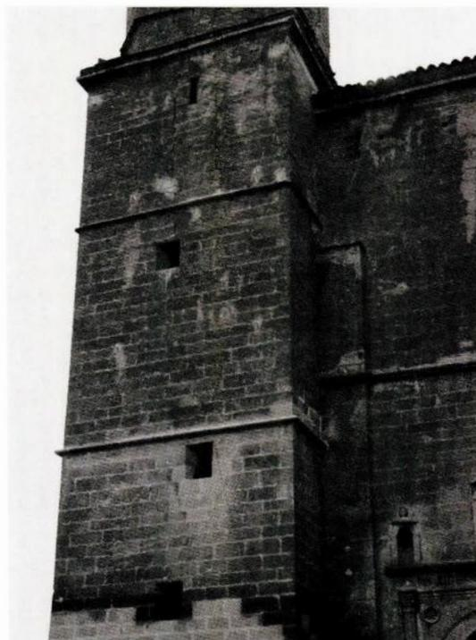
Cara sur de la torre. Aspilleras para iluminación. Obsérvese el muro entre la torre y la portada, de difícil justificación. La toma permite apreciar cómo resulta claro que la torre no fue concebida como parte del templo, sino que corresponden a construcciones diferentes.
