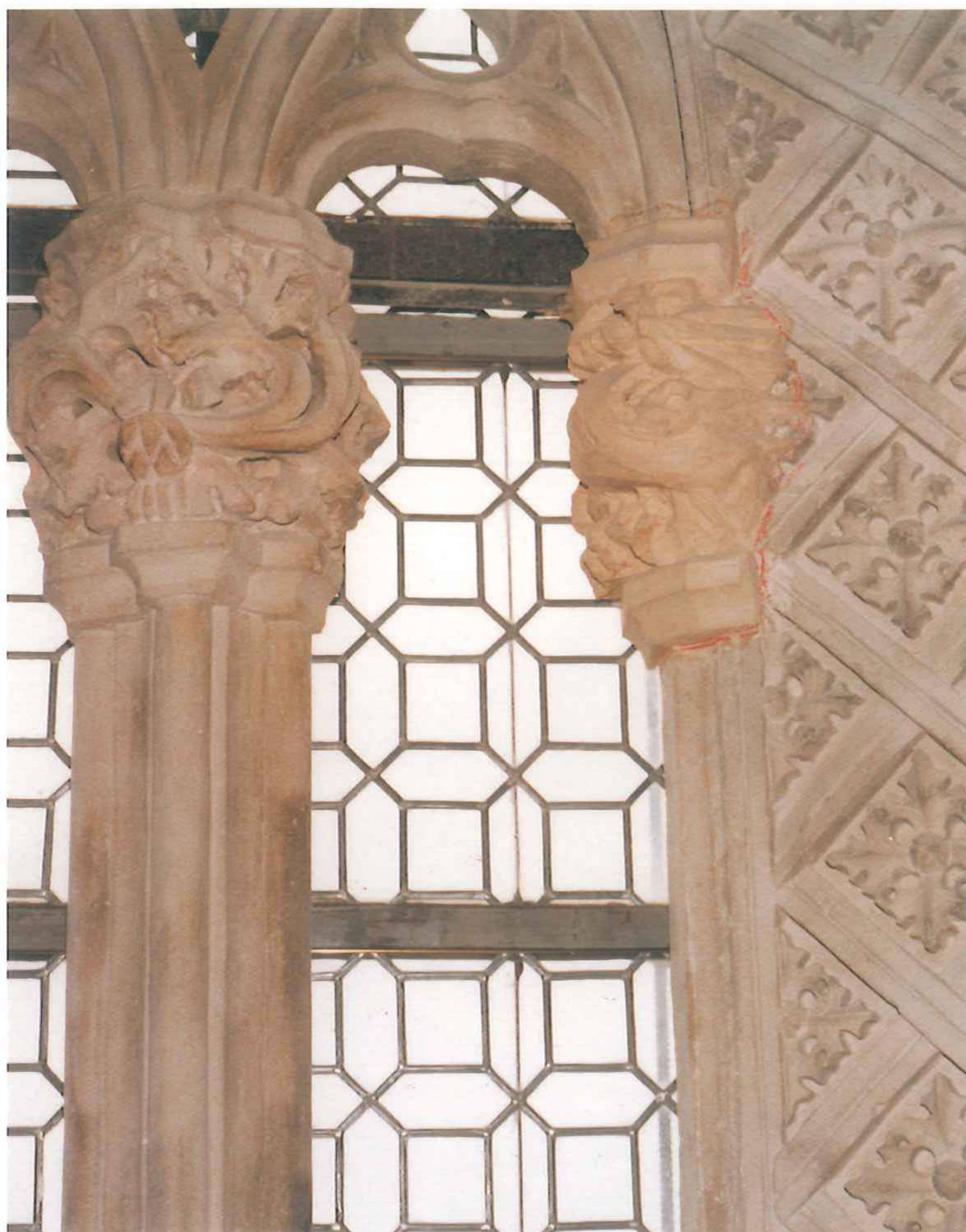
Detalle de un ventanal. Címborio. Enero 1996. Foto: Rafael Palacio de Parada.
