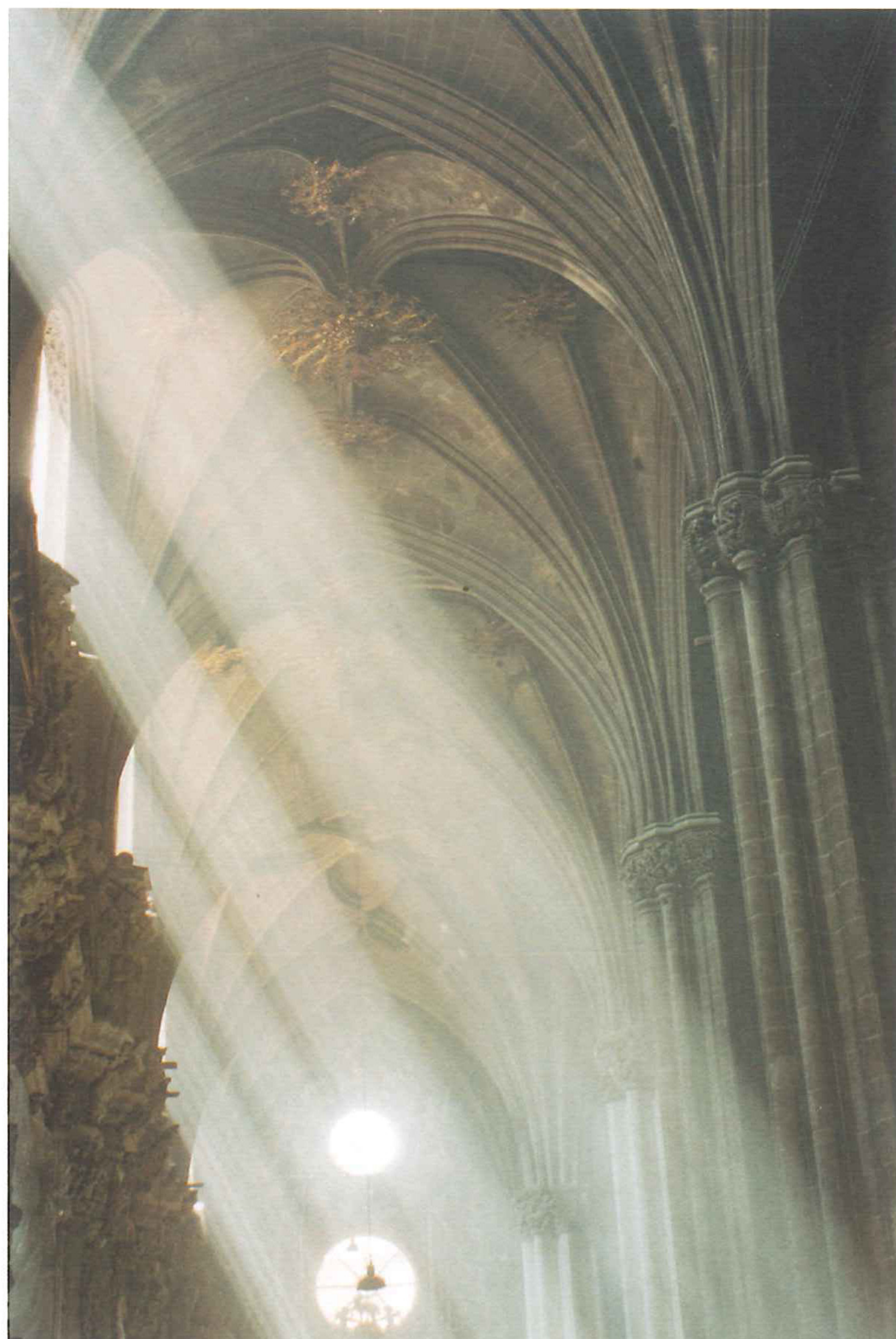
Vista general del transepto antes de la restauración. Mayo 1994. Foto: Francisco Fes.
