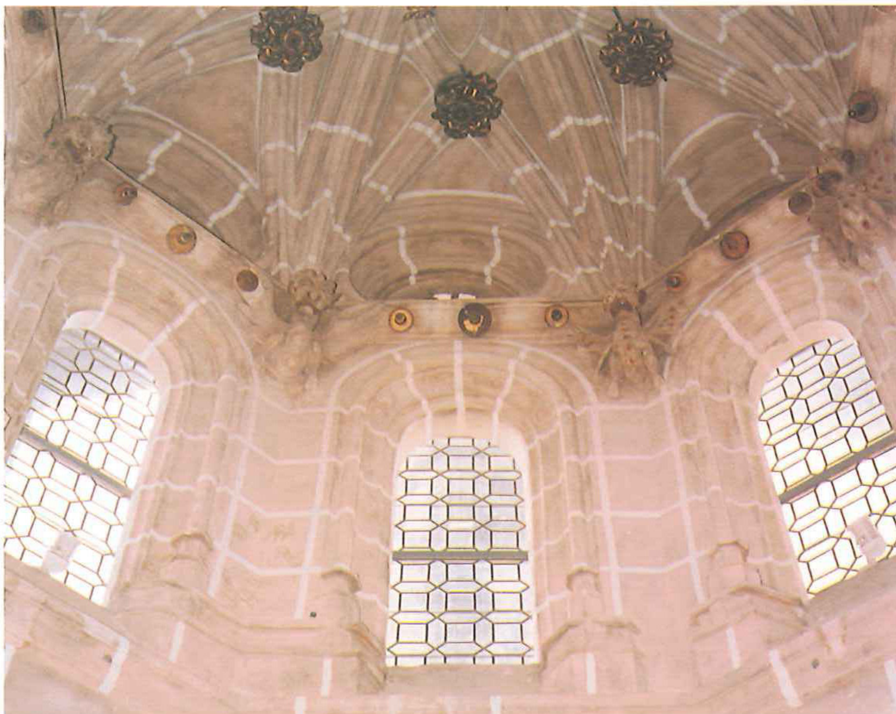
Detalle de la linterna. Cimborrio. Enero 1996. Foto: Rafael Palacio de Parada
