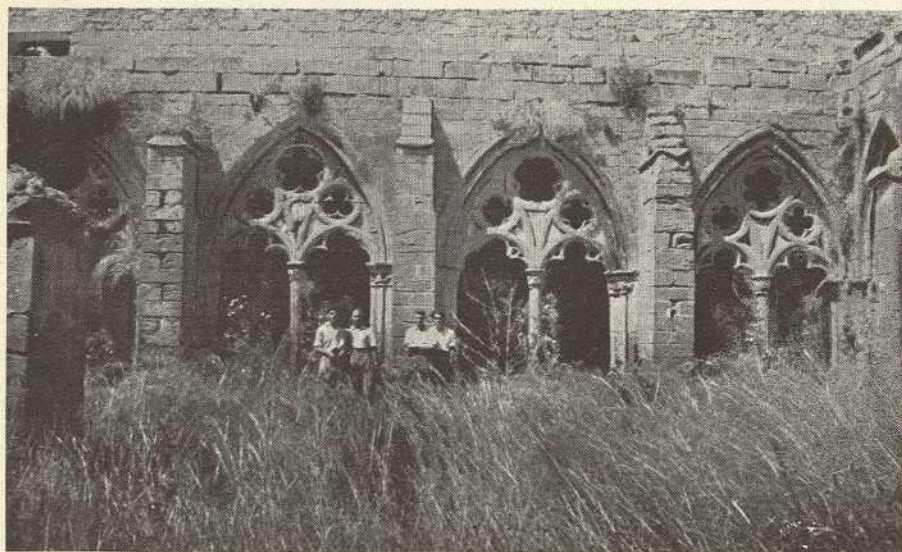
VENTANALES GÓTICOS DEL CLAUSTRO QUE, ABANDONADOS, VAN DESAPARECIENDO.
