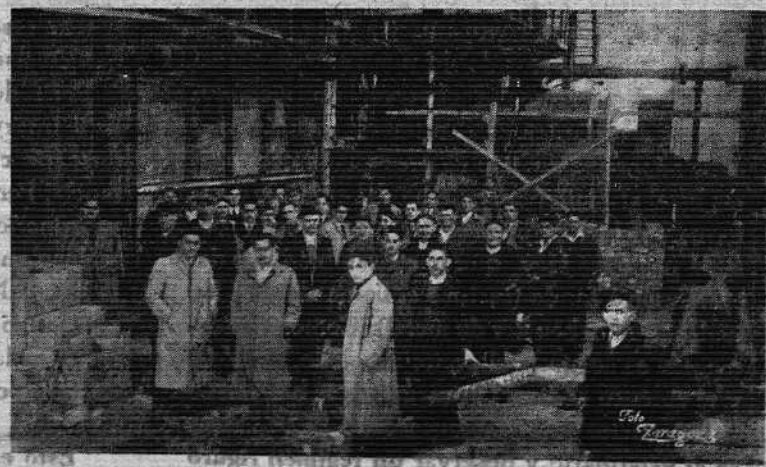
Los cursillistas en su visita a la Central Térmica de Aliaga
