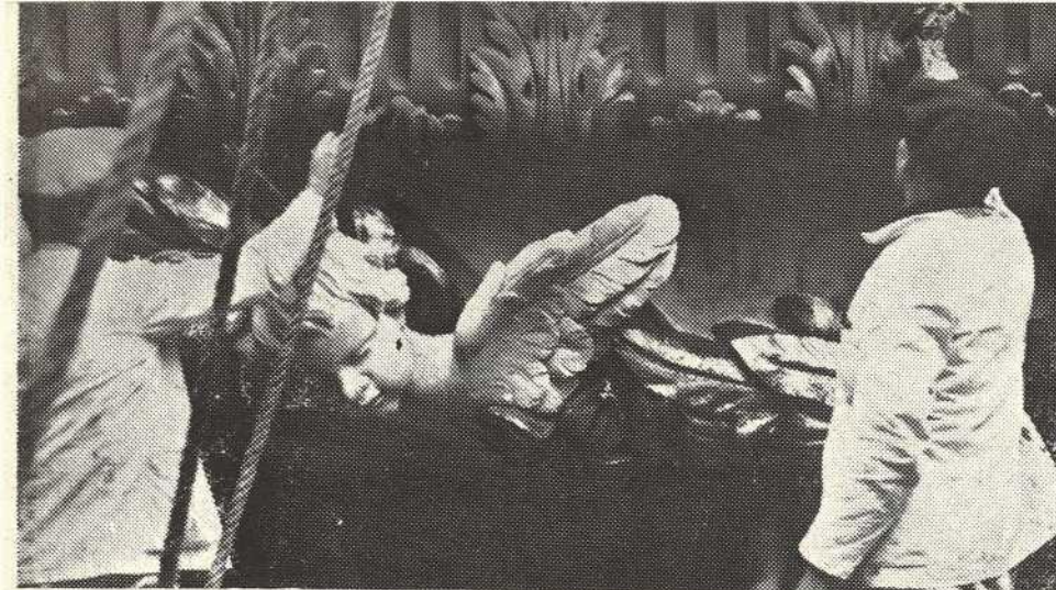
En lo más alto de la cúpula, antes de quitar los andamios, los obreros decoradores proceden a reparar los desperfectos causados al cerrar las grietas.
