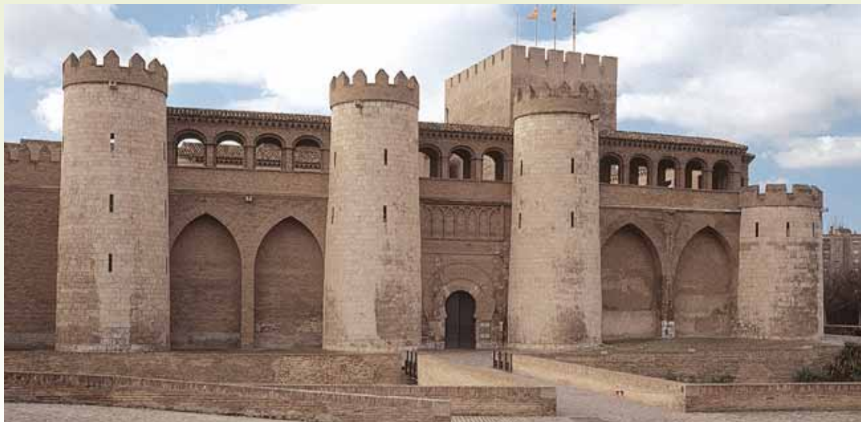
La Aljafería de Zaragoza.
