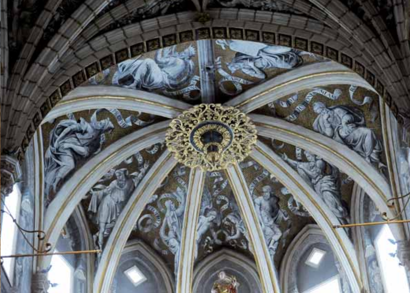
Detalle de la bóveda del ábside, con las pinturas renacentistas descubiertas durante la restauración.
