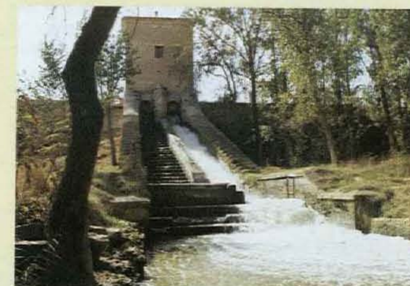
Murallas de Grisén. El control de aguas en el kilómetro 58.
