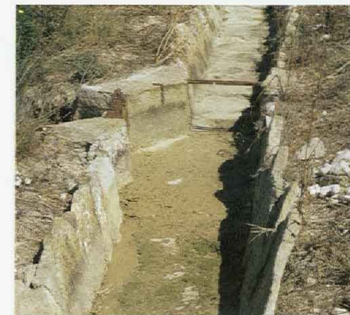
Acequia artesanal revestida con losas de piedra en Monegros I (Huesca).
