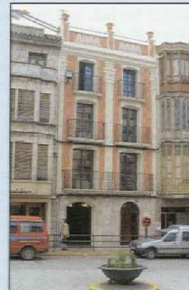
Histórico. Fachada de la sede de la OCA en Fraga.
