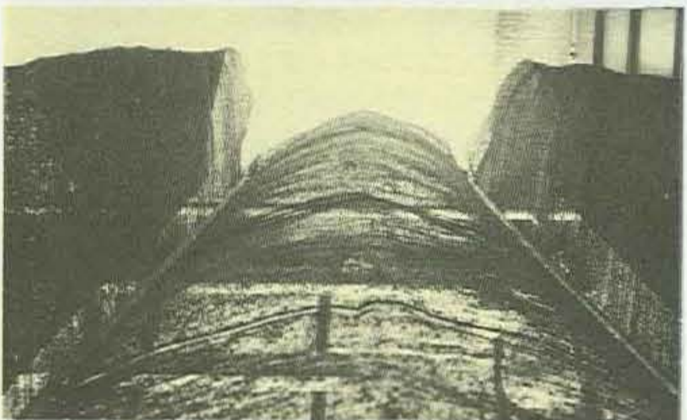
Figura 5. El sombreado interior no mejora sensiblemente el rendimiento del sistema de refrigeración evaporativa.
