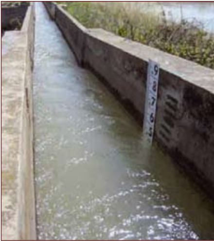
Foto 1. Control de nivel de altura en acequias.
