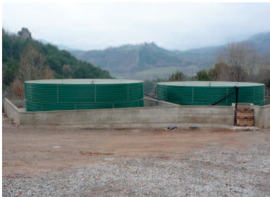
Abajo: Imagen de parte de las instalaciones del antiguo vertedero de Bailín, donde se centran ahora los trabajos del Gobierno de Aragón.
