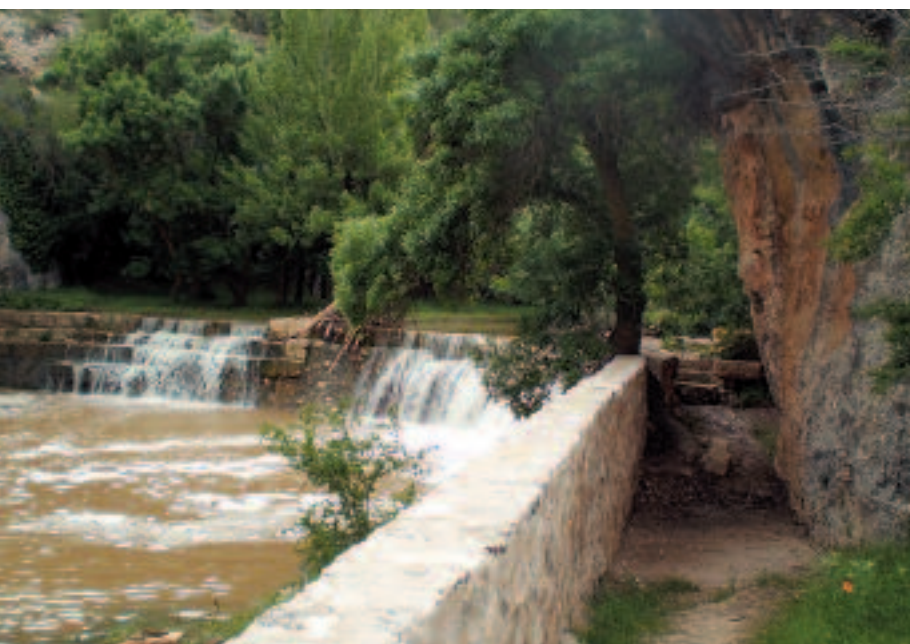
Azud en el Río Piedra, en Torralba de los Frailes.
