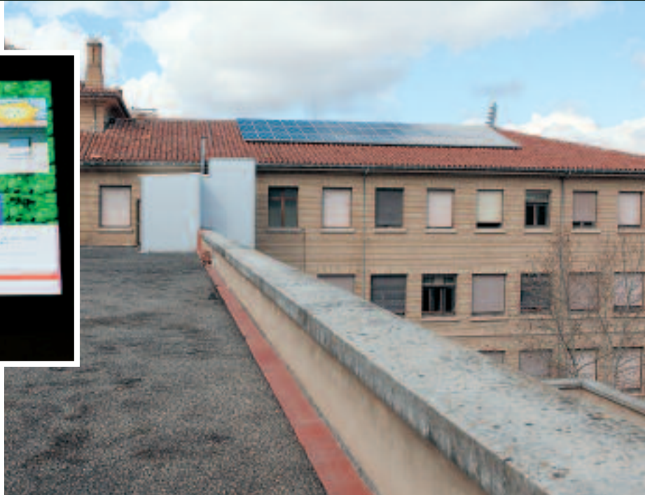
Placas solares en el tejado del instituto y panel instalado en el hall.
