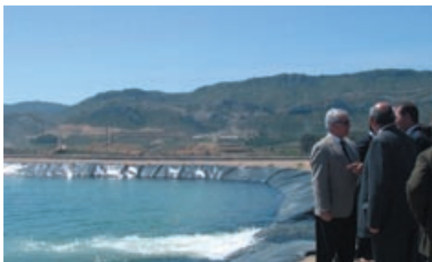
Teruel. Una de las cuatro balsas construidas en Calanda.
