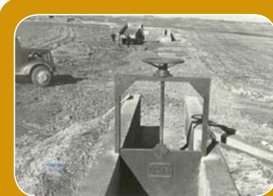
Construcción de acequias en los años 50.
