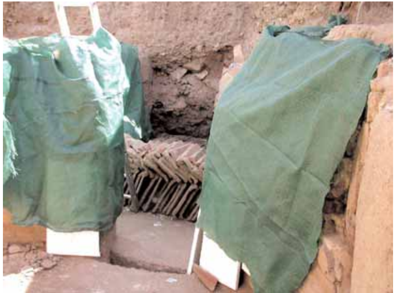
Protección final de los muros con pintura mural.
