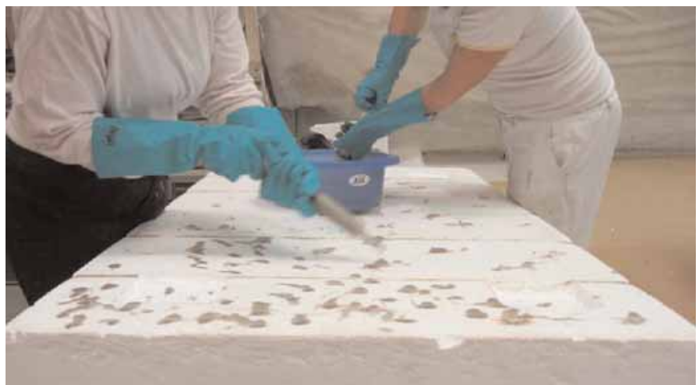
Inyectado de epoxi.
