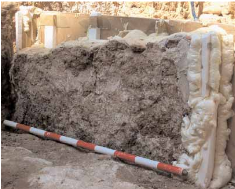
Muro espumado y rebajado preparado para su arranque.
