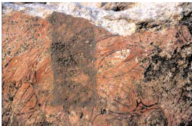
Testigo mostrando el estado de suciedad inicial en el zócalo de la estancia C.
