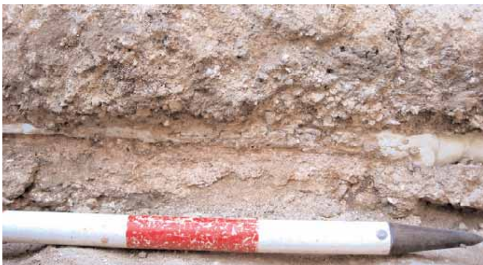
Detalle del corte inferior del muro visto por el reverso.
