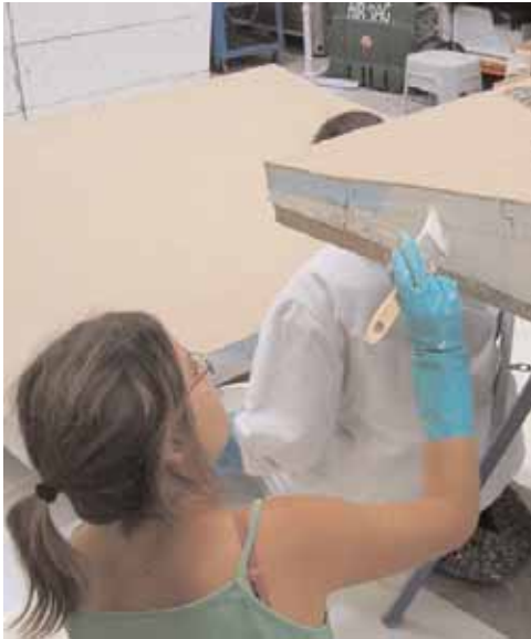
Pintura de protección de los paneles.
