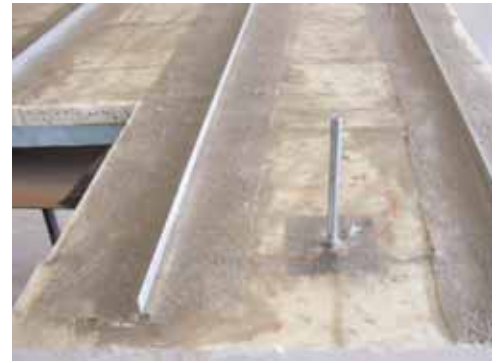
Detalle de los anclajes.
