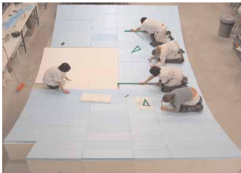
Replanteo de los corchos de poliestireno extruído.
