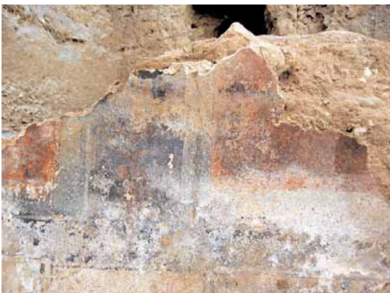
Eflorescencia salina sobre la capa pictórica.
