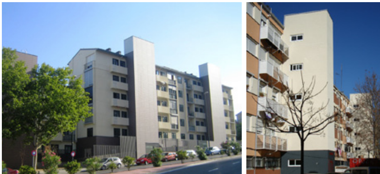
Uno de los criterios básicos de la rehabilitación consiste en la utilización de energías alternativas
