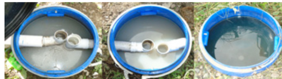
Figura 2 los tanques de pre-tratamiento y almacenamiento
