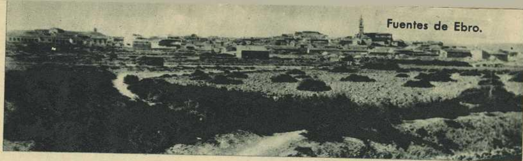
Vista parcial de Fuentes.
