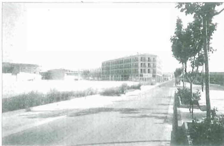
El segundo ensanche de Ejea está considerado dentro de la modificación del P. G. de Ordenación Urbana. En la foto, el Paseo de la Constitución.
