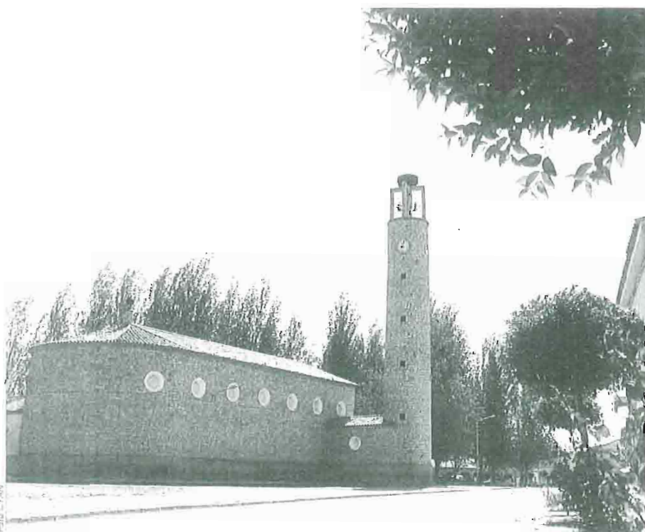
En El Sabinar existe una cooperativa de cableado con 15 socios-trabajadores
