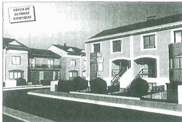
Urbanización «Residencial Vega de Luchán» Ejea
