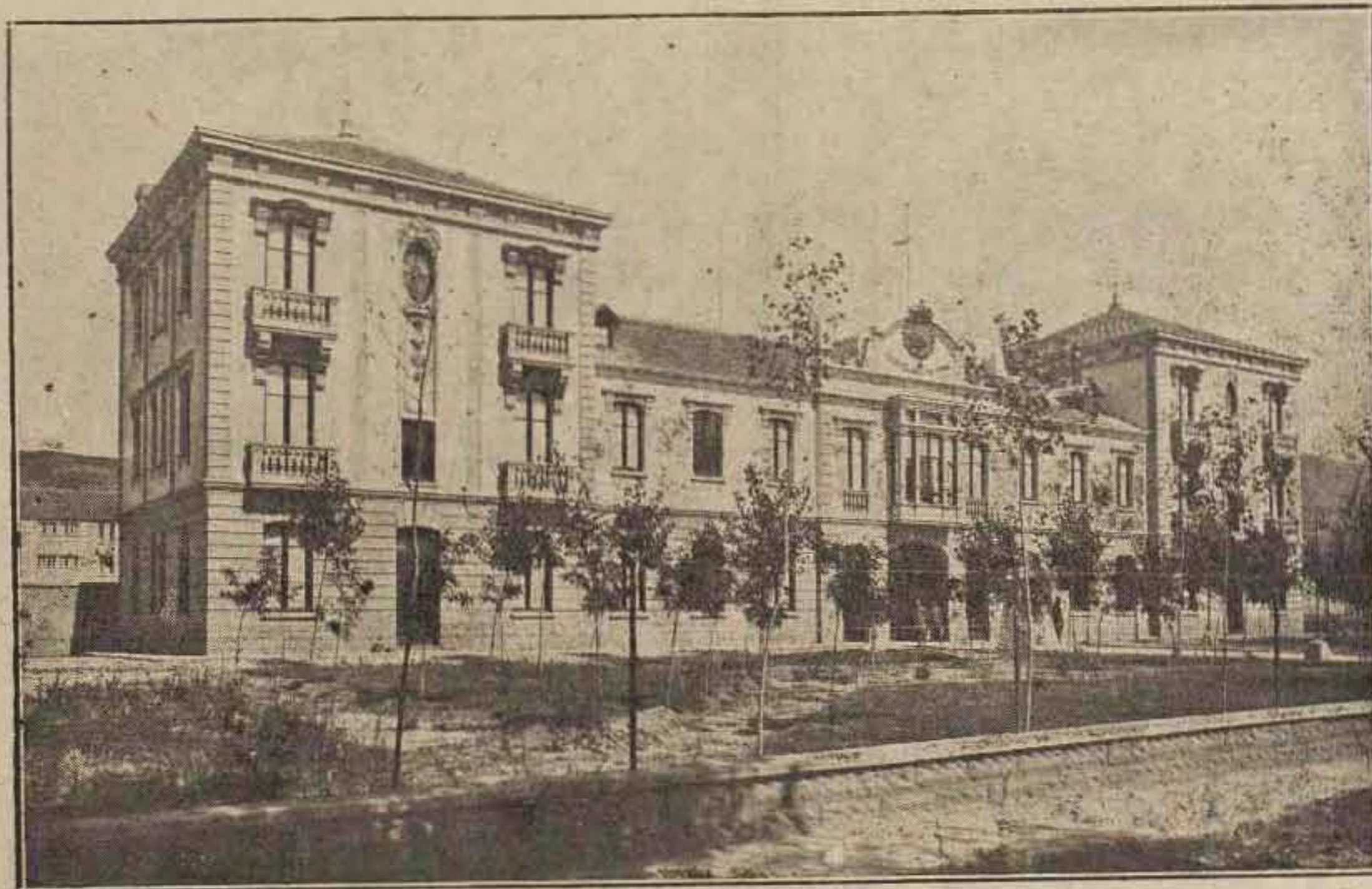
CUARTEL DE LA VICTORIA
