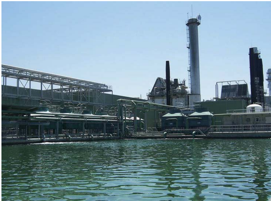
Planta de cogeneración de biogás de 7,5 MW (Zaragoza)
