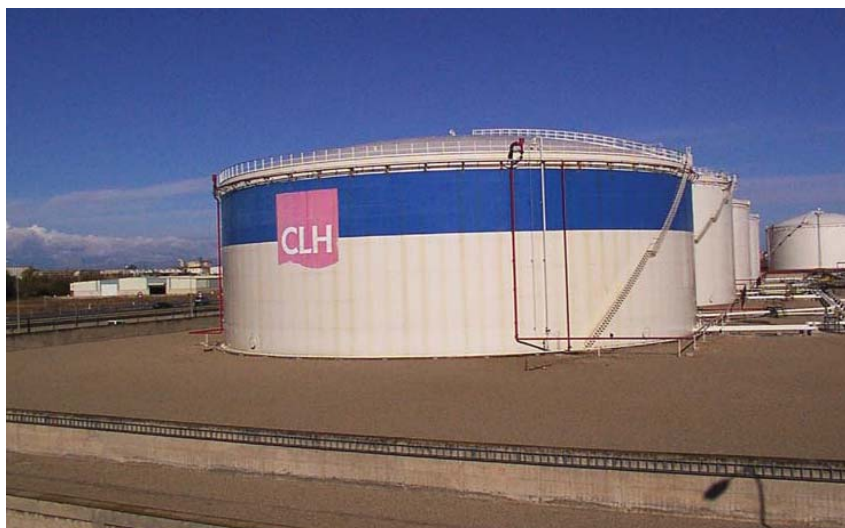
Compañía Logística de Hidrocarburos (Zaragoza)
