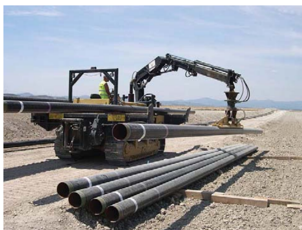
Construcción de gaseoductos en la Comunidad Autónoma de Aragón.
