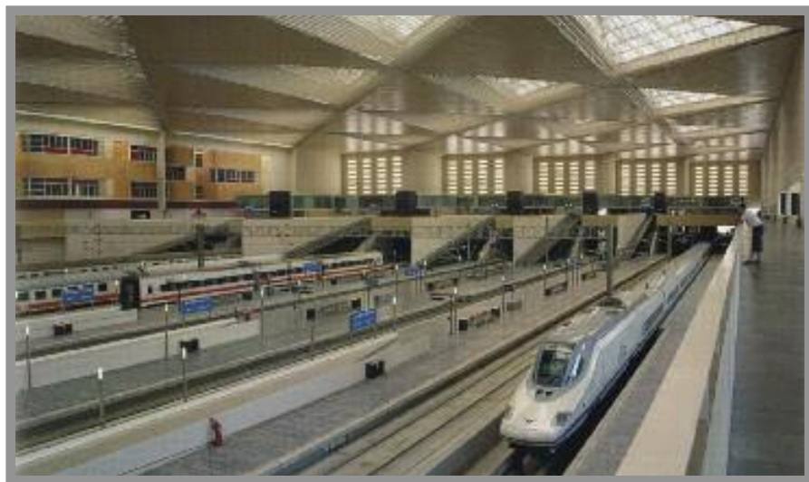
Estación Intermodal de Zaragoza
