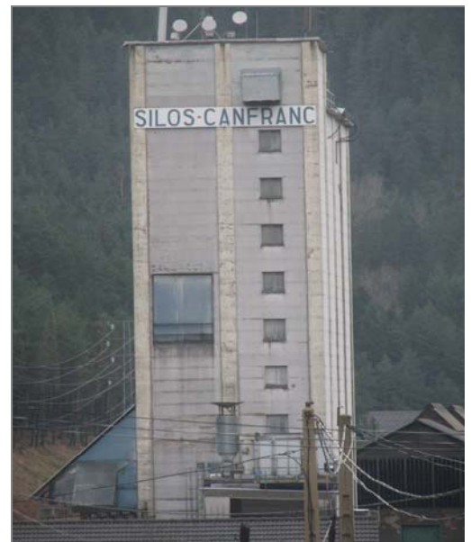
Figure 8. Détail des installations de Silos Aragonais de Canfranc
