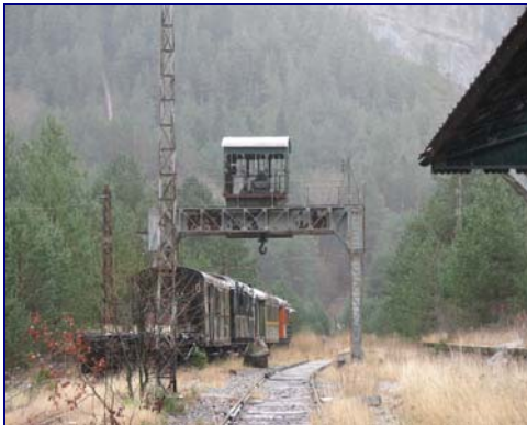
Figure 9. Détail de l'état actuel des installations abandonnées
