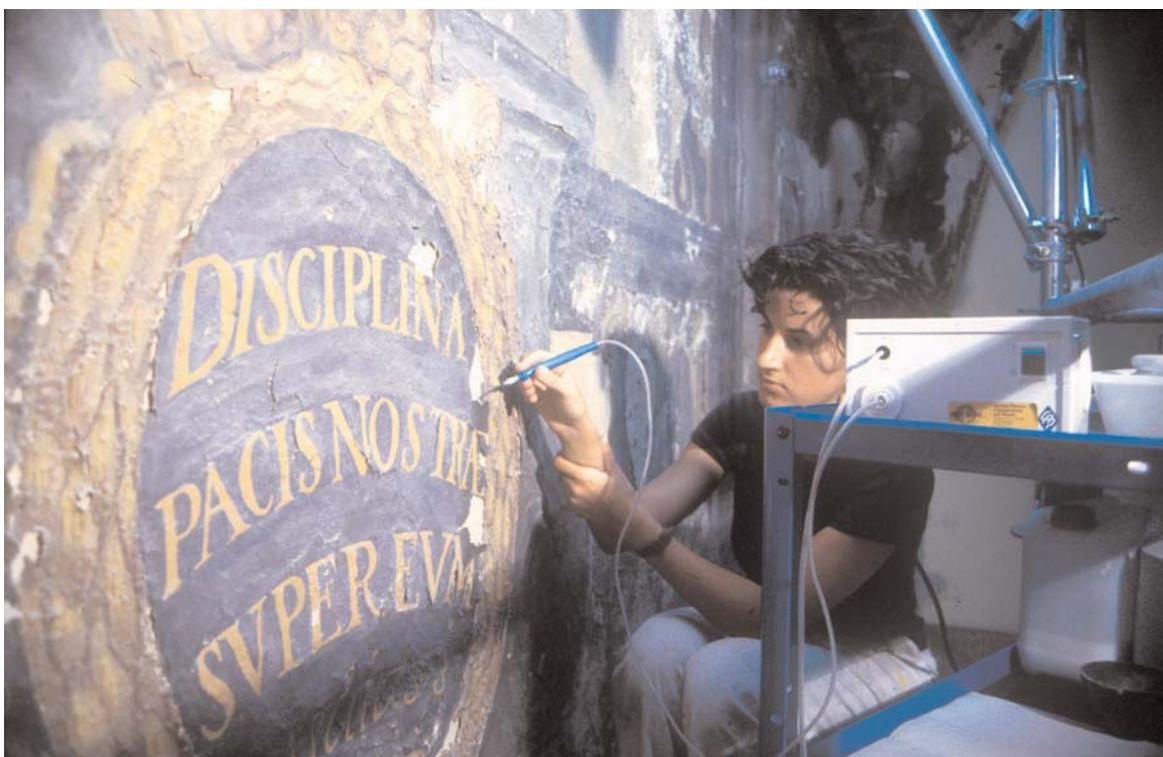
*Alumna restauradora eliminando los depósitos de mortero disgregados entre la pintura y el revoque*
